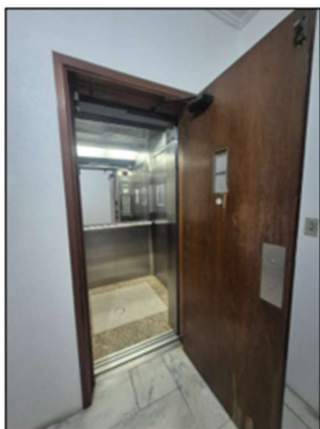
Figura 12 - Interior EL2 no 11º andar.
