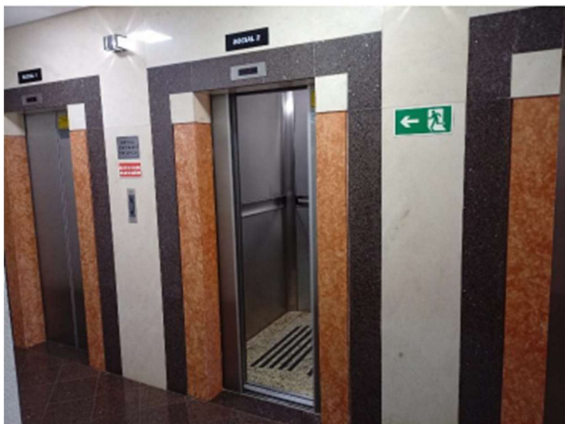
Foto 16 – elevadores nos andares.
