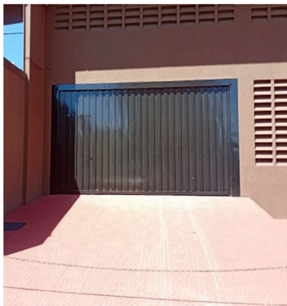
Foto 3 – acesso a área de carga/descarga.
