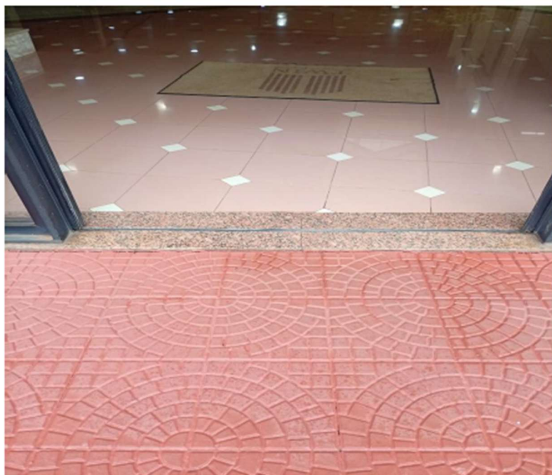
Foto 7 – porta de correr no acesso principal.
