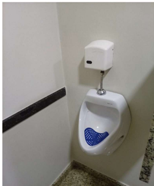
Foto 24 – mictório no sanitário coletivo.
