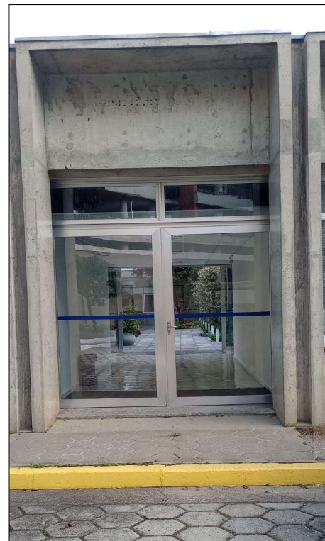
Figura 9 - Acesso secundário da edificação.
