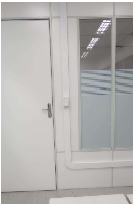
Figura 42 - Altura padrão dos interruptores 110cm.
