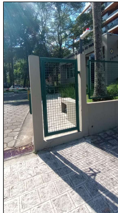
Figura 19 – Degrau no acesso de pedestres.
