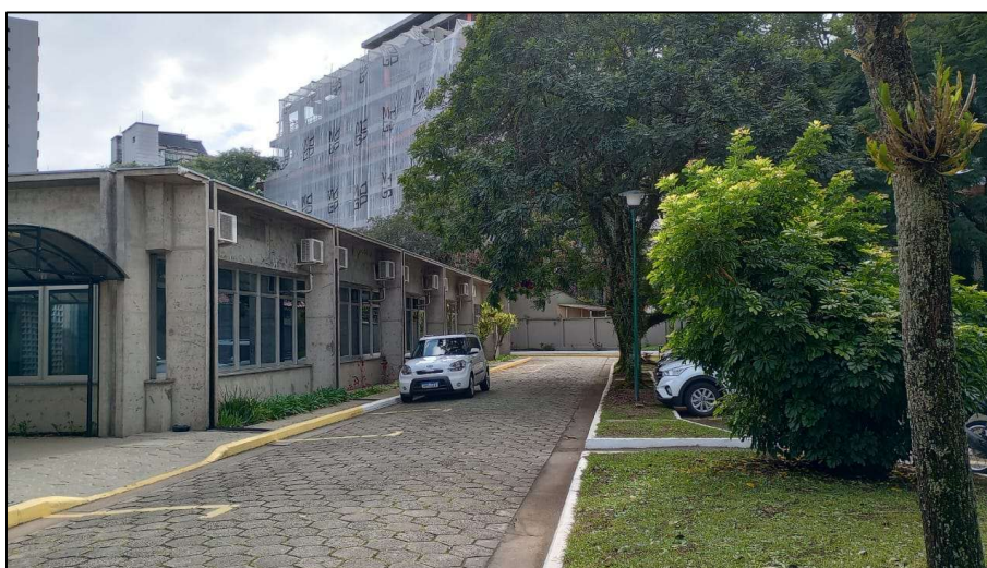
Figura 14 - Estacionamento lateral na área externa.
