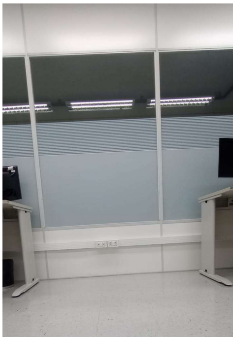
Figura 41 - Altura padrão das tomadas 30 cm.
