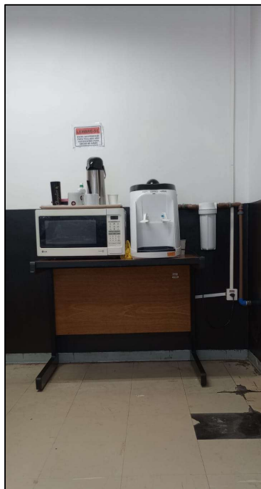
Figura 36 - Bebedouros com instalações não acessíveis, localizados nas copas.
