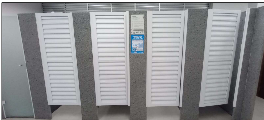
Figura 35 - Portas internas do sanitário coletivo.
