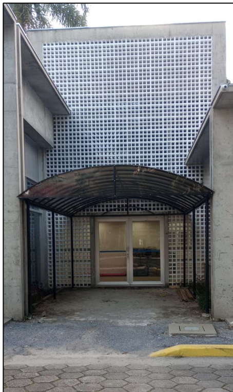
Figura 8 - Acesso principal da edificação.
