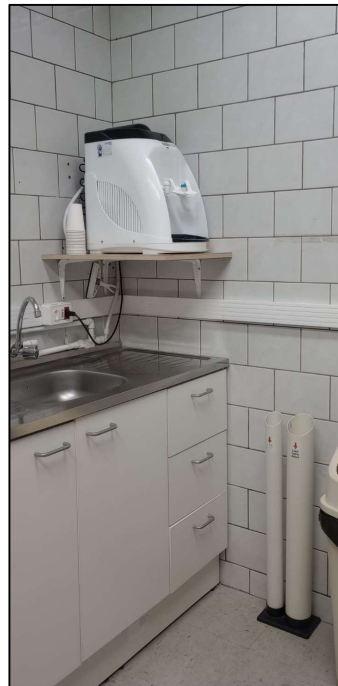
Figura 36 - Bebedouros com instalações não acessíveis, localizados nas copas.
