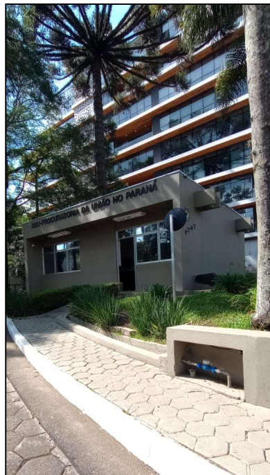
Figura 18 - Rampa no acesso de pedestres.
