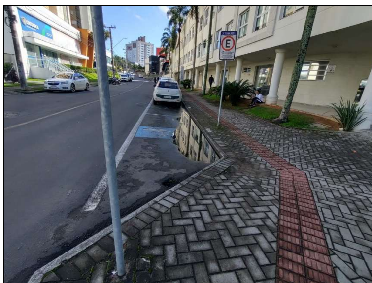
Figura 4 - Calçada na rua Afonso Celso.
