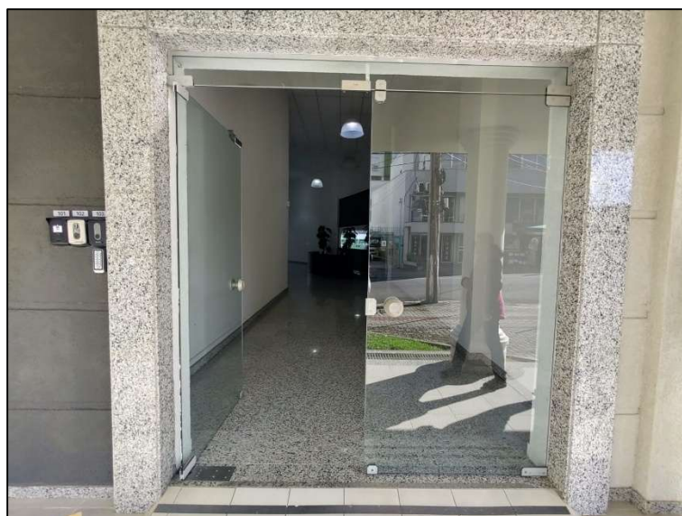
Figura 7 - Porta de acesso principal.
