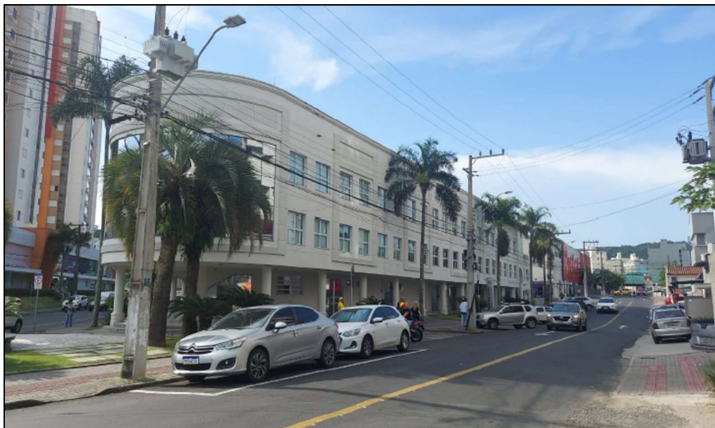
Figura 1 - Fachada rua Des. Pedro Silva.
