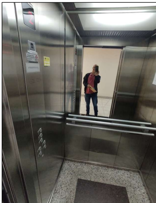
Figura 16 - Foto interna do elevador.
