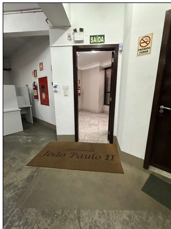
Figura 14 - Porta de acesso do G1 à circulação vertical.
