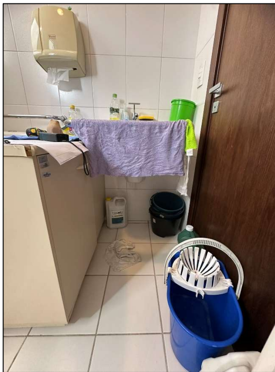
Figura 45 - Sanitário adaptado - lavatório.
