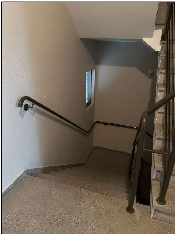
Figura 24 - Guarda-corpo e corrimão entre os lances da escada.
