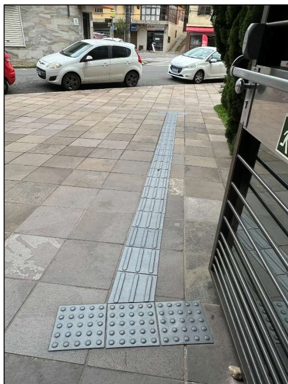
Figura 2 - Piso tátil instalado na edificação.
