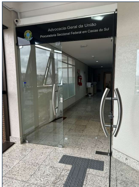
Figura 31 - Porta de acesso à PSF - 5º andar.
