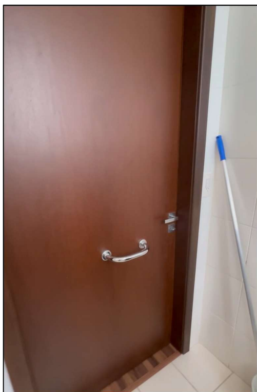
Figura 39 - Vista interna da porta do sanitário adaptado.
