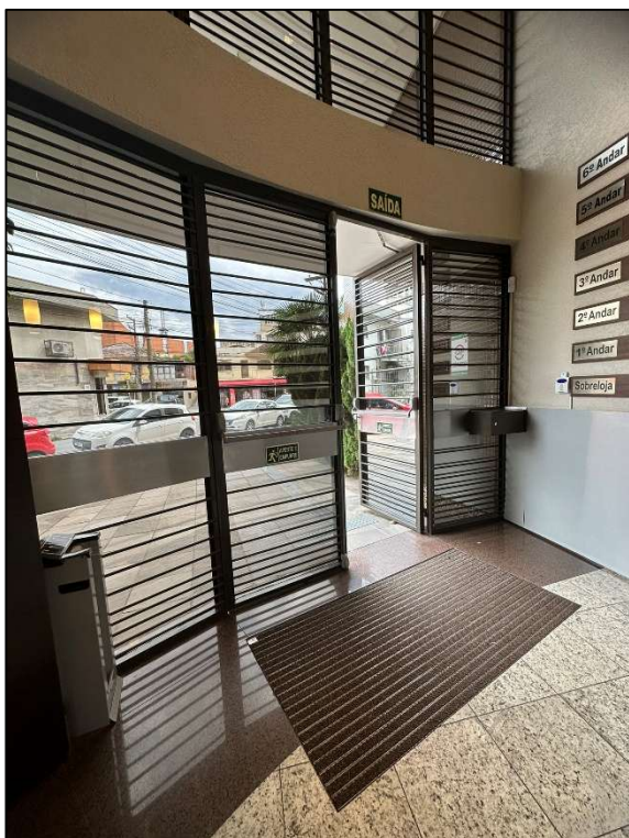
Figura 15 - Porta de acesso à edificação.
