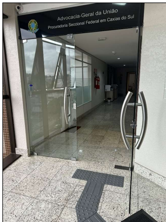
Figura 35 - Porta de acesso à unidade no 5º andar.
