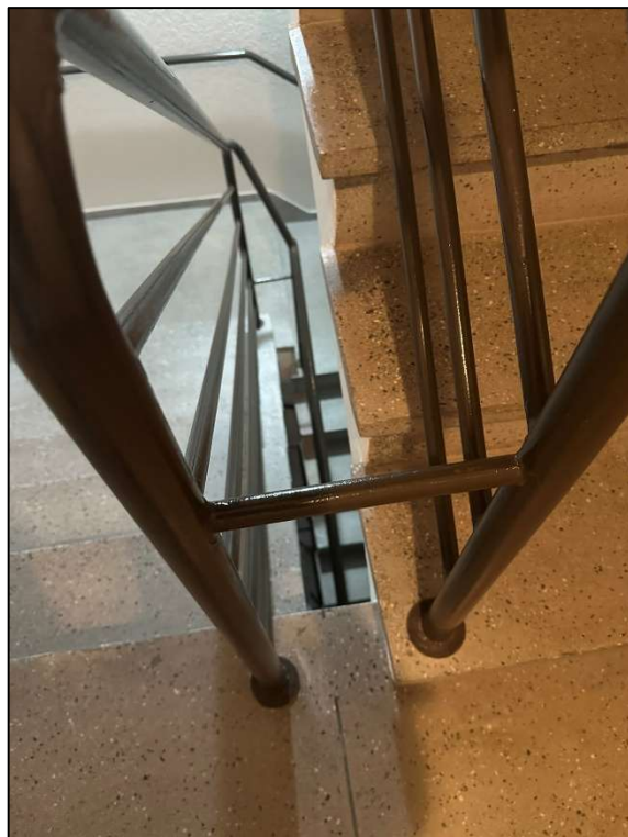
Figura 23 - Guarda-corpo e corrimão entre os lances da escada.
