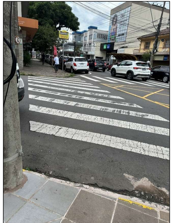
Figura 4 - Rebaixo da calçada na rua Mariana Prezzi.
