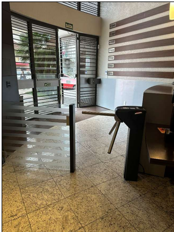
Figura 11 - Controle de acesso: catraca e portinhola.
