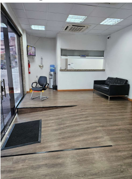
Foto 05 - Hall de entrada
