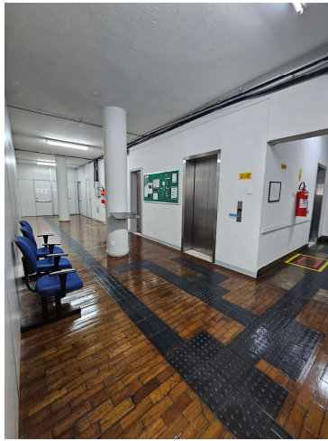
Foto 04 - Corredor 4º pavimento
