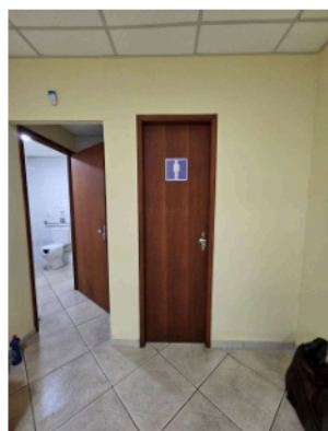
Foto 09 - Portas dos sanitários
