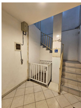
Foto 05 - Hall do acesso secundário/acessível
