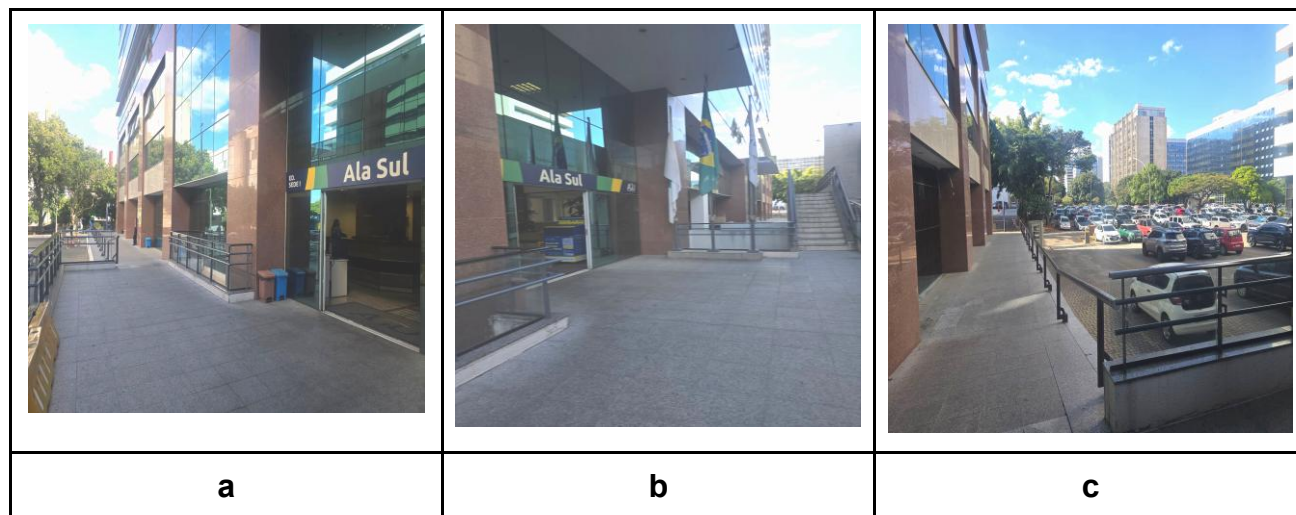
FOTO 2: O prédio possui duas entradas, pela Ala Sul (SAUS Q.3) ( foto 2.a. ) e pela Ala Norte (rua SAUS Q2.) ( foto 2.c. ). as Alas não possuem comunicação externa acessível devido à presença de uma escada ( foto 2.b. ).
