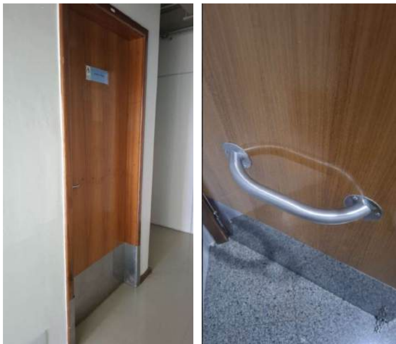
Foto 38 – 6º andar. Porta sanitário.
