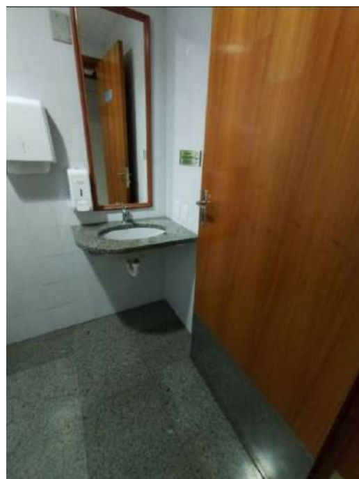
Foto 52 – 6º andar. Sanitário acessível.
