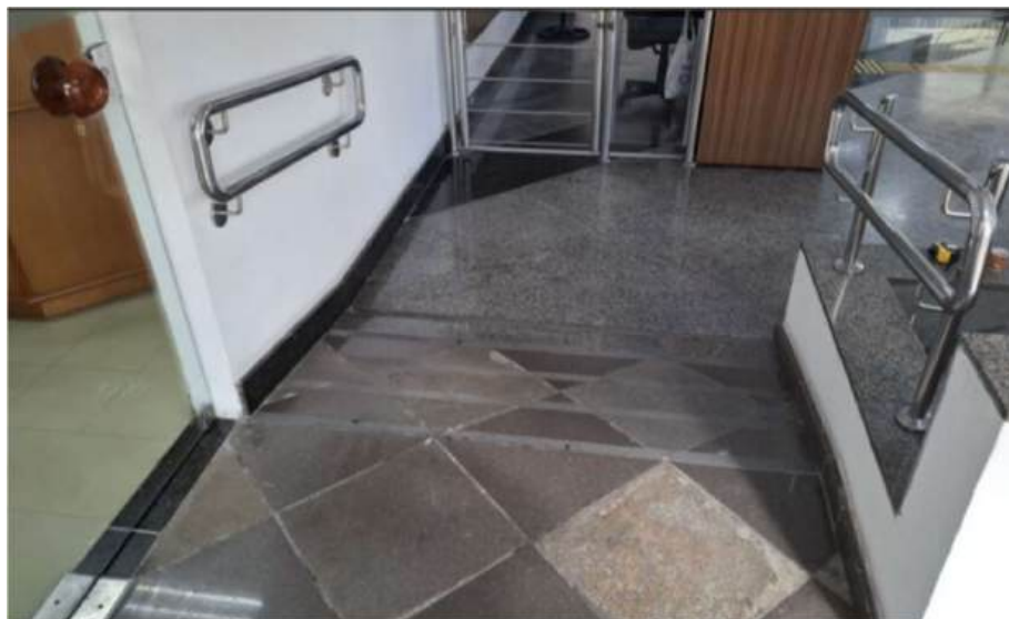
Foto 25 – térreo. Rampa para acesso ao protocolo.
