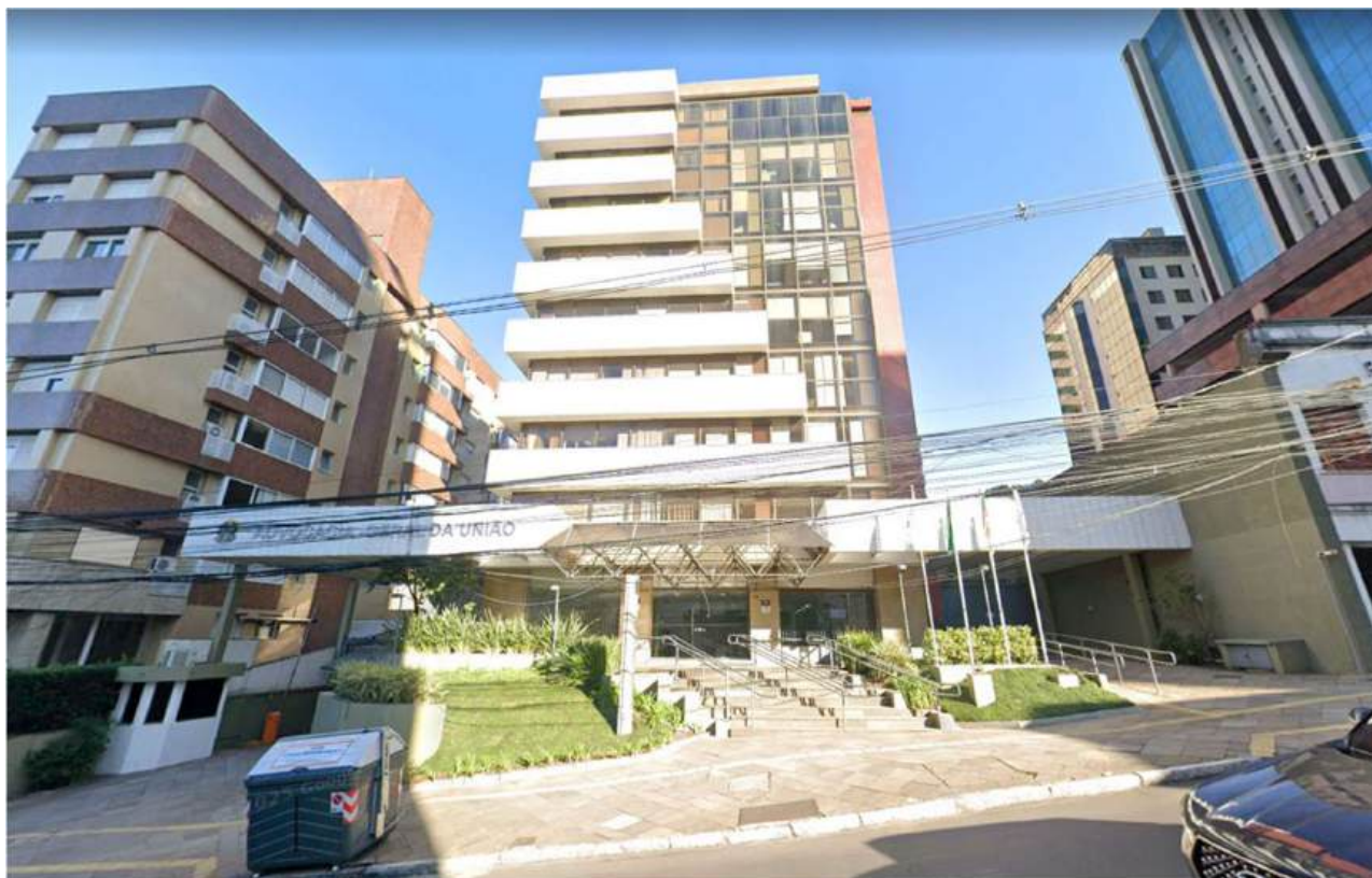
Foto 1 – térreo. Vista frontal edificação .
