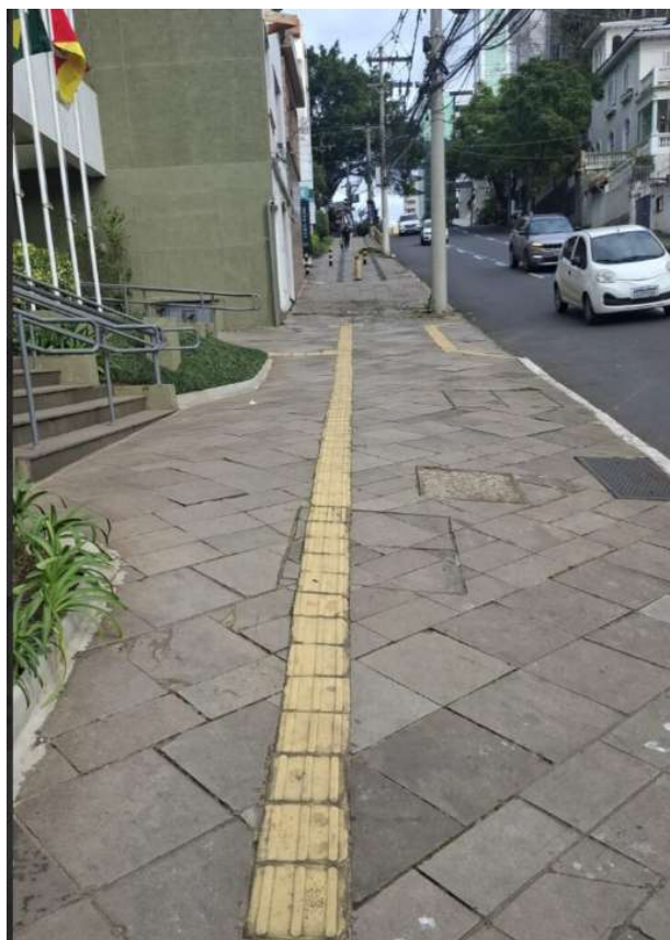
Foto 2 – térreo. Calçada externa junto à via.
