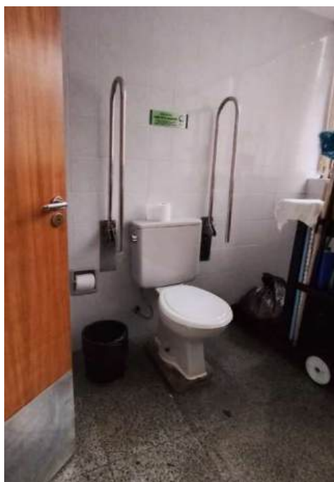
Foto 48 – 3º andar. Sanitário acessível.
