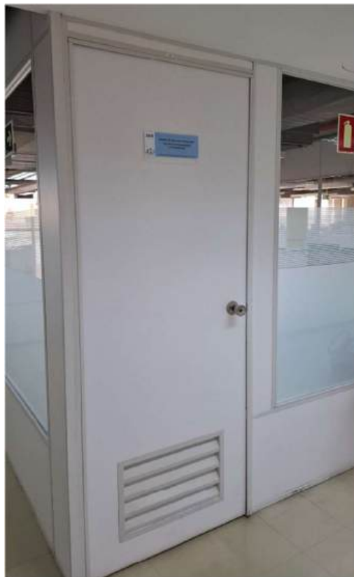
Foto 72 – pavimentos tipo. Padrão de sinalização de portas – visual.
