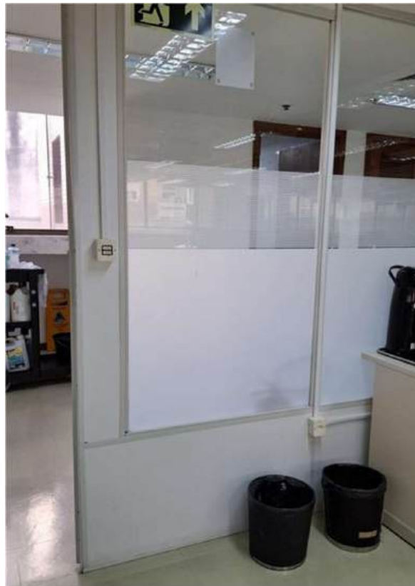
Foto 69 – pavimentos tipo. Altura padrão de interruptores e tomadas.
