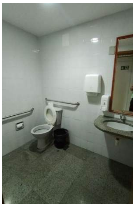
Foto 51 – 6º andar. Sanitário acessível.
