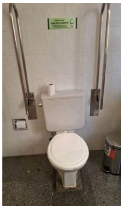
Foto 49 – 3º andar. Sanitário acessível.
