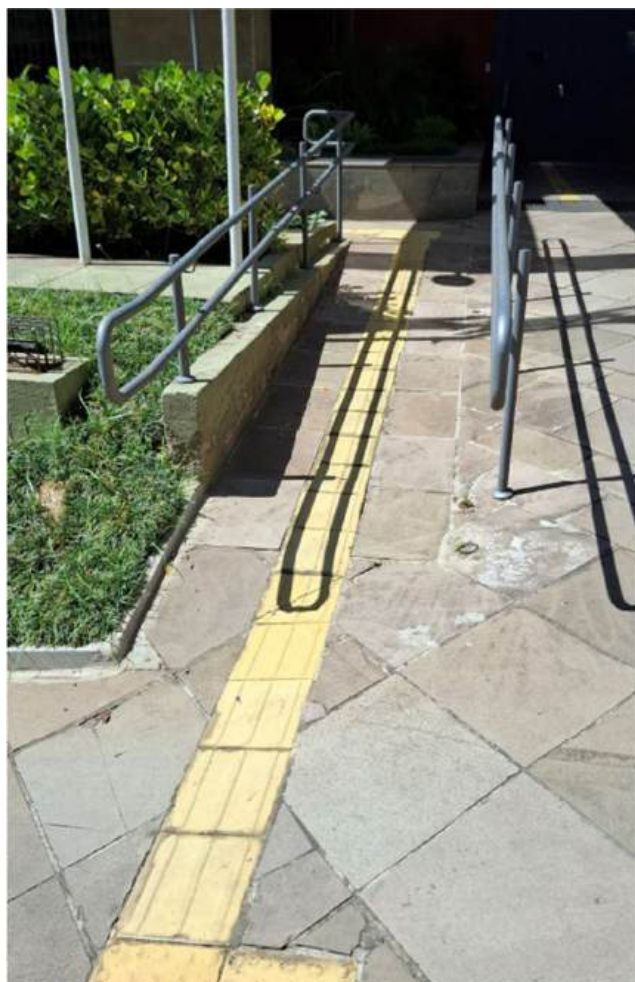
Foto 7 – térreo. Rampa de acesso à entrada principal.
