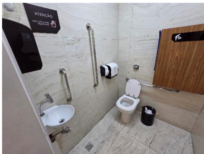
Fotografia 13 - Aspecto interno do banheiro acessível.
