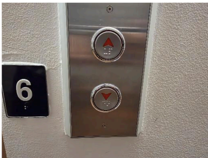
Fotografia 2 - Placa indicativa de andar e botoeira dos elevadores com inscrição em Braille.
