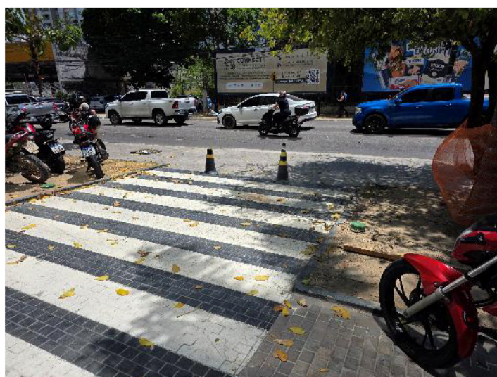
Fotografia 5 - Acesso entre calçada e condomínio sem desníveis.
