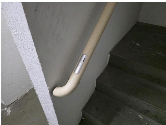
Fotografia 18 - Identificação em Braille nos corrimões das escadas.
