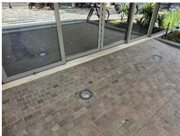
Fotografia 7 - Ausência de desnível em acesso ao Corporate .
