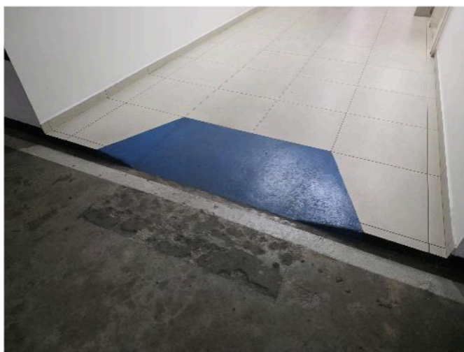
Fotografia 1 - Rampa de acesso em desníveis no subsolo.
