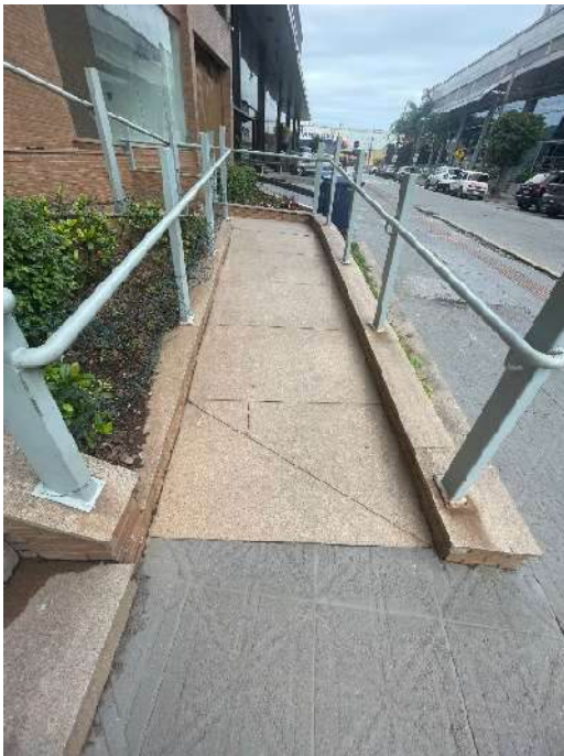
Figura 7 – térreo – rampa acesso fundos.
