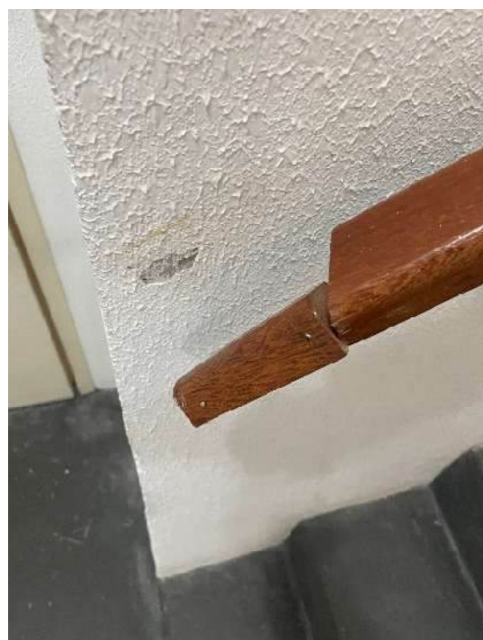
Figura 19– 6º pavimento – escada de emergência.
