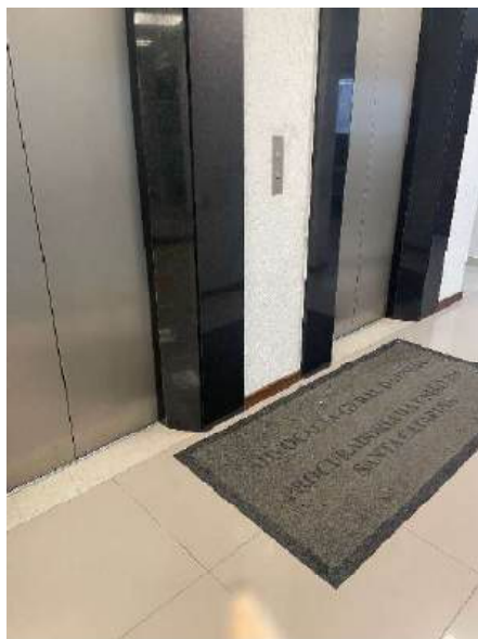
Figura 12 – 6º pavimento – hall elevadores.
