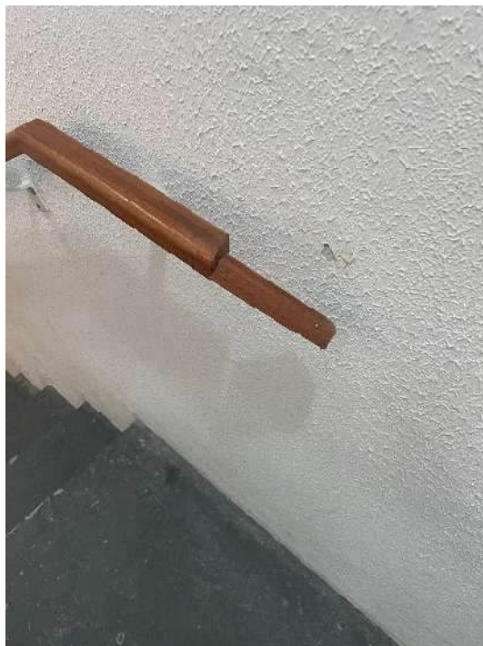
Figura 18 – 6º pavimento – escada de emergência.
