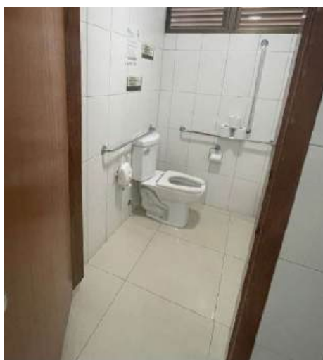
Figura 26 – 5º pavimento – sanitário acessível.
