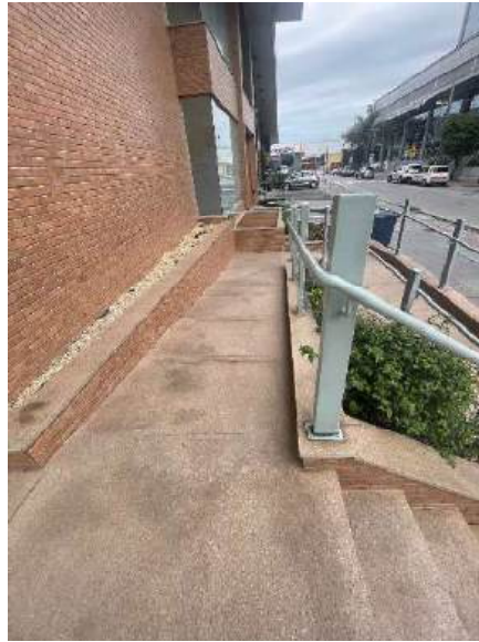
Figura 9 - térreo – escada acesso fundos.
