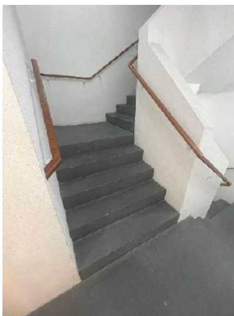
Figura 16 – andares – escada de emergência.
