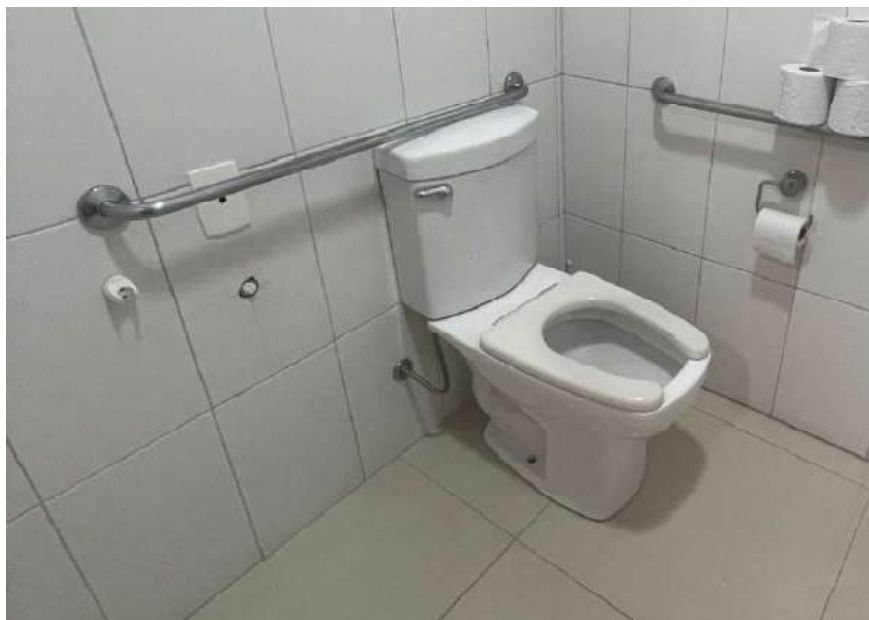
Figura 24 – 6º pavimento – sanitário acessível.
