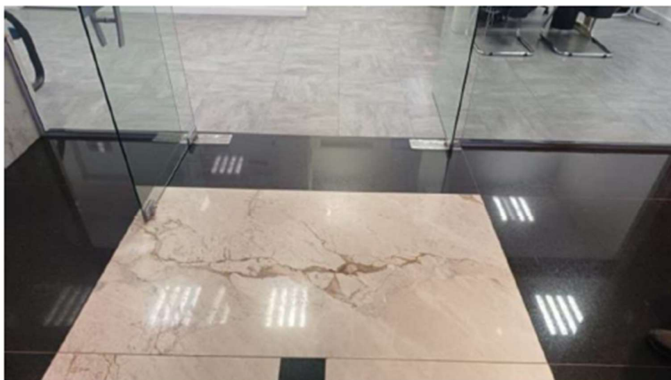
Foto 8 - hall dos andares.
