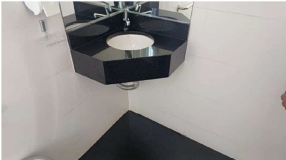
Foto 9 - lavatório sanitário PCD.
