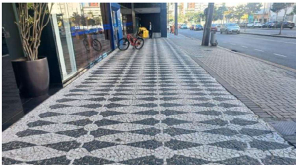
Foto 3 - calçada em frente à edificação.
