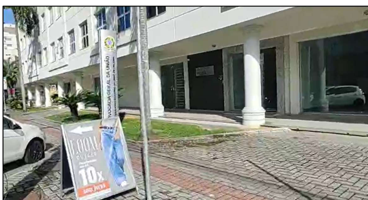
Figura 5 - Acesso à unidade.
