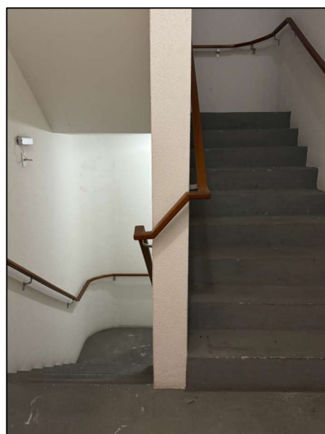
Figura 15 - Escada de emergência - ESC1.
