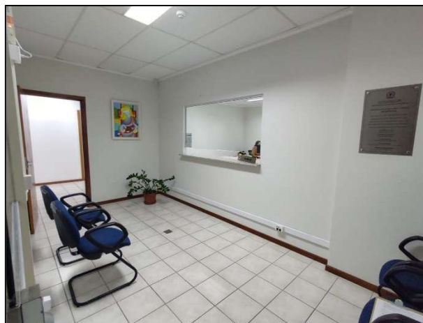
Figura 24 - Balcão no acesso à unidade, com altura de 1,2m.
