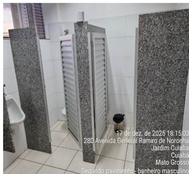
Foto 86: 2º Pavimento - Ban. Masculino
