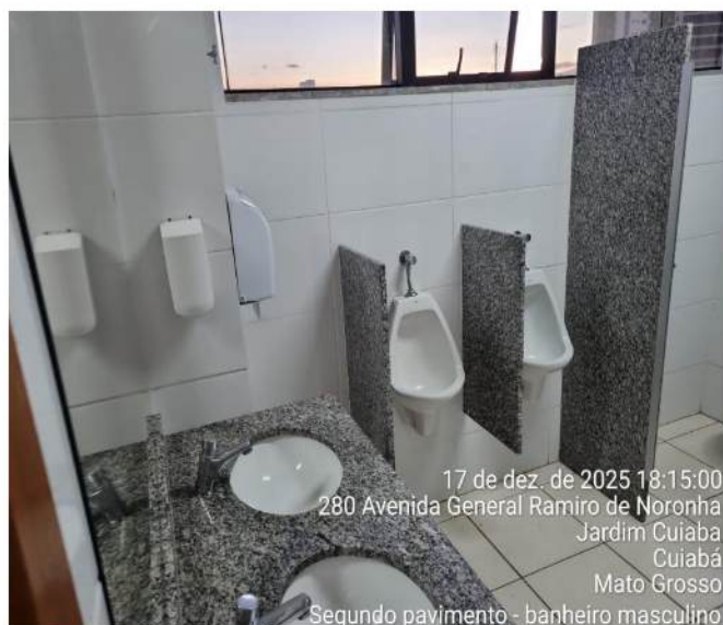
Foto 85: 2º Pavimento - Ban. Masculino
