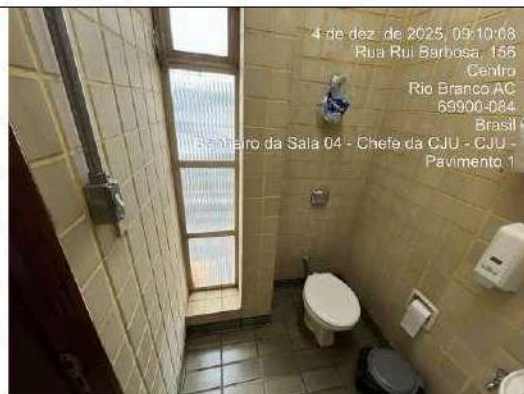
Foto 44: 1º Pavimento – Ban. Sala 4
