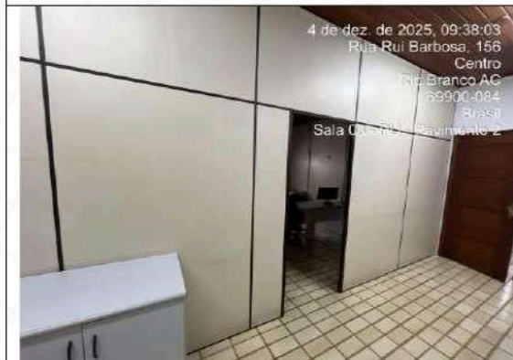
Foto 59: 2º Pavimento – Sala 3
