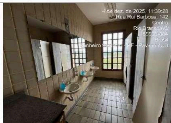
Foto 68: 3º Pavimento – Ban. Feminino
