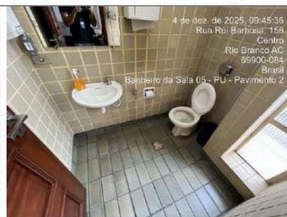
Foto 62: 2° Pavimento – Ban. Sala 5
