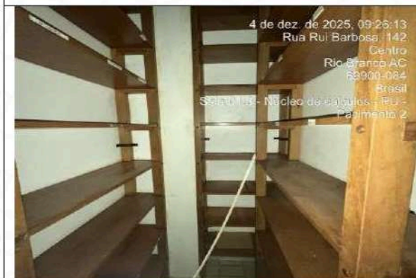
Foto 53: 2º Pavimento – Sala 1.3
