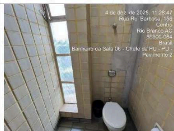
Foto 64: 2° Pavimento – Ban. Sala 6
