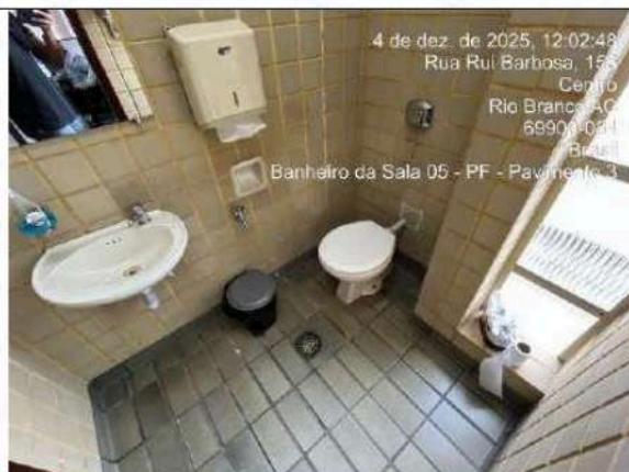
Foto 77: 3º Pavimento - Ban. Sala 5
