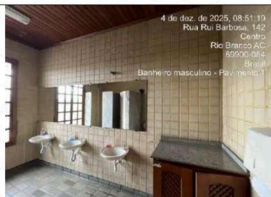
Foto 35: 1º Pavimento – Ban.
