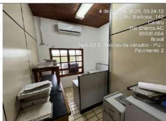
Foto 52: 2º Pavimento – Sala 1.2
