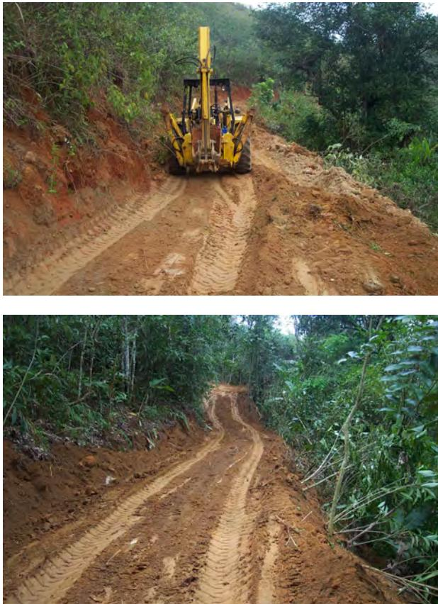
Figura 3 – Retroescavadeira sistematizando a superfície da estrada e resultado após o serviço. É possível visualizar a superfície e as laterais do leito com solo suscetível à erosão hídrica.
