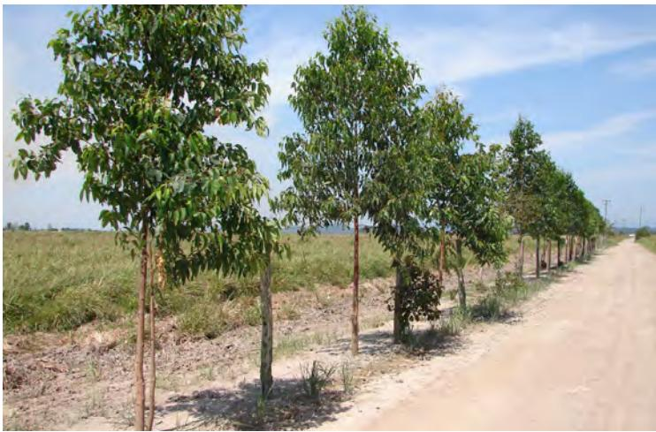
Figura 5 – Plantio de espécie arbóreas na lateral da estrada facilitando a sinalização de limite do seu leito.
