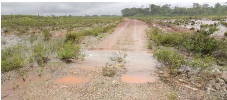
Figura 7 – Detalhe da drenagem insuficiente no leito, ocasionando excesso de água na via.
