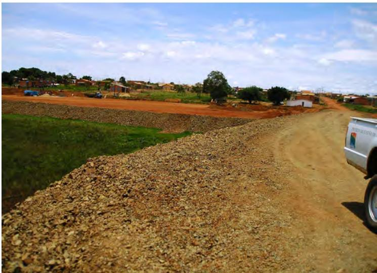
Figura 13 – Material de revestimento do leito da estrada com granulometria grosseira, mais cascalhenta.
