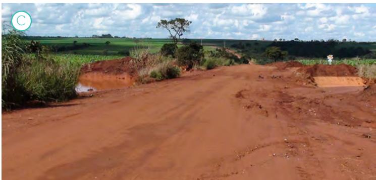
Figura 10 - Bacia de retenção implantada em área marginal (A), em área de cultivo (B) e na lateral da estrada (C).
