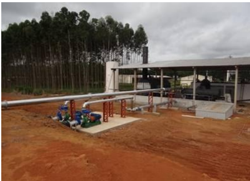
Fazenda Toledo: construção de usina movida a biogás para produção de energia elétrica.
