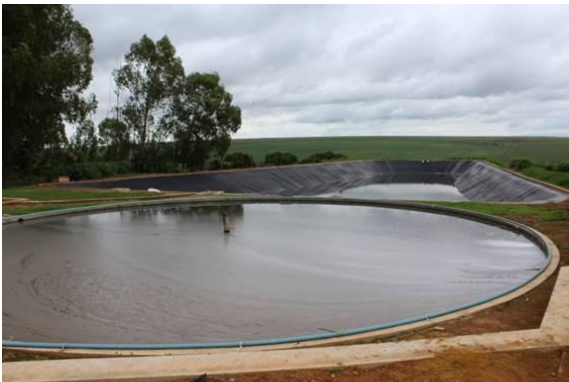
Tanque de aeração e lagoa de estabilização
