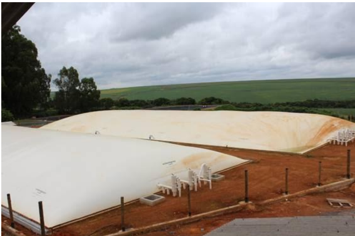
Biodigestores em funcionamento
