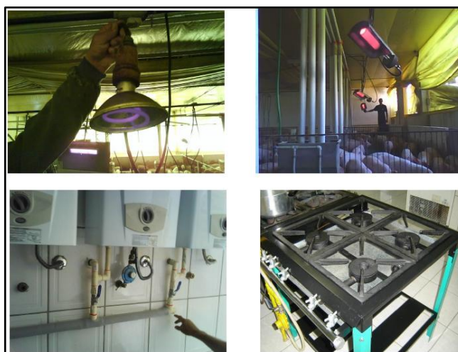
Figura 1 - Uso do biogás na forma direta através da queima e geração de energia térmica
