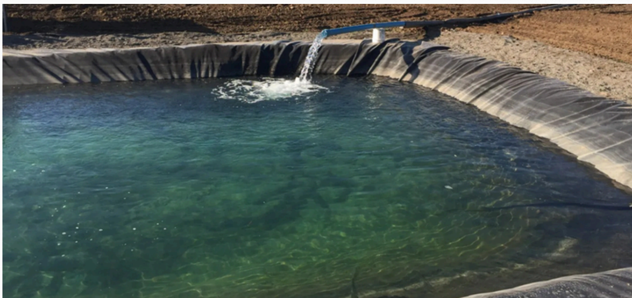
Imagem 2 - Geomembrana para tanques de irrigação.
