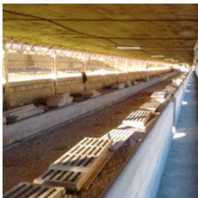
FIGURAS 33, 34 e 35: exemplo prático de conversão de granja de gestação de celas para o sistema de gestação coletiva em minibox. Neste exemplo os ferros oriundos das celas serviram para confecção dos boxes e das divisórias, otimizando assim o material existente na granja.
