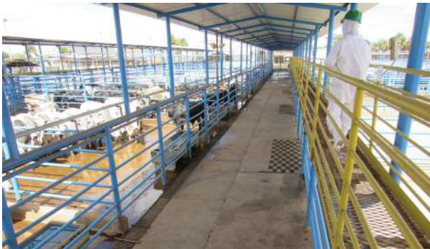
Verificação das instalações para o recebimento dos bovinos após o desembarque.
