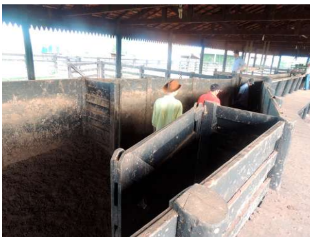
Verificação e reparos das estruturas do curral de manejo.
