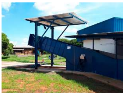
Rampa de desembarque com as laterais fechadas, evitando paradas e distrações
