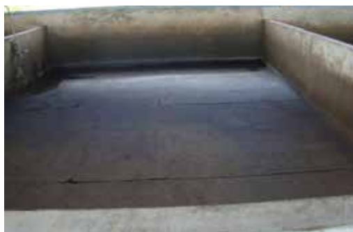
Figura 35. Baia com piso compacto.
