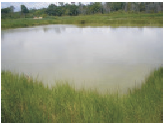
Figura 7. Tanque escavado em terreno natural.
