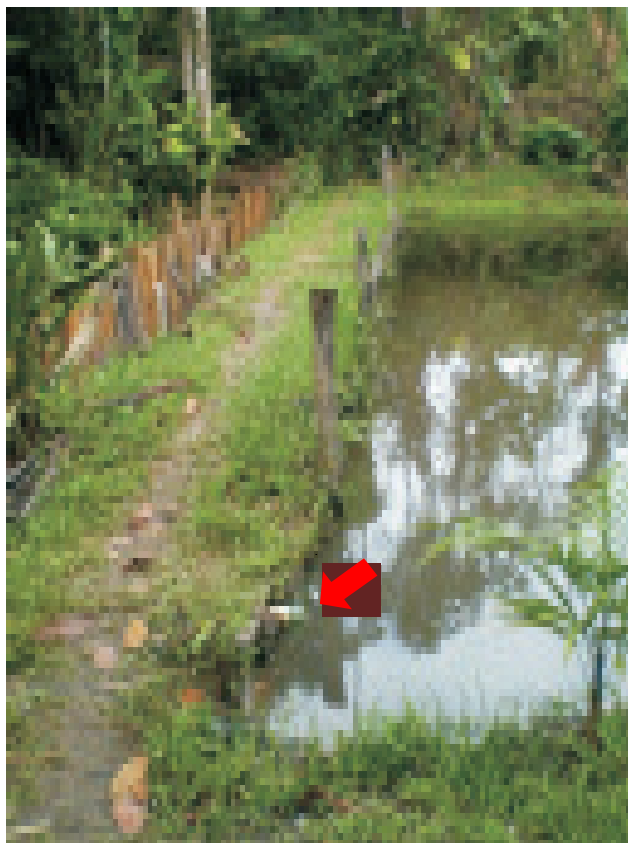
Figura 5. Sistema auxiliar para escoamento da água (ladrão).
