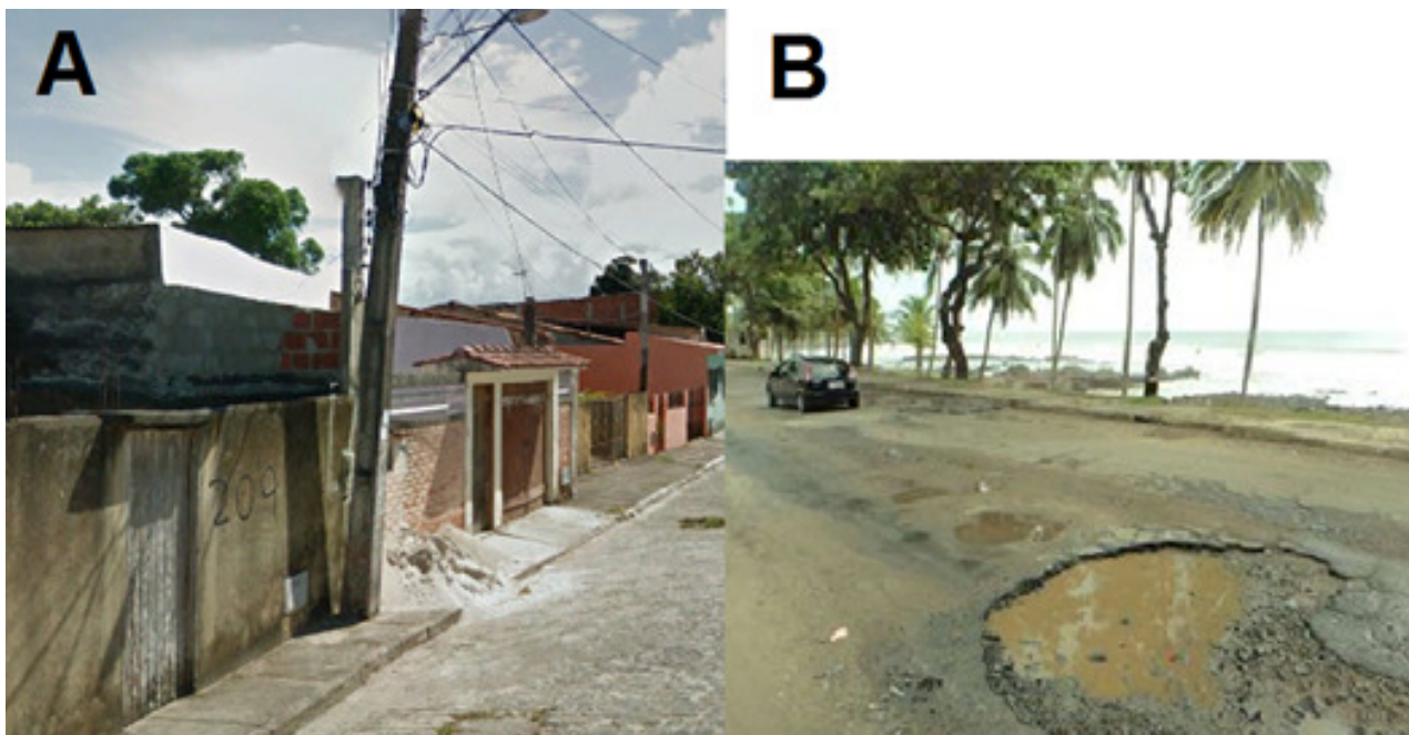
Figura 6 – A) Poste inclinado no Bairro Nelson Costa; B) Cavidade formada na rodovia BA 001.
