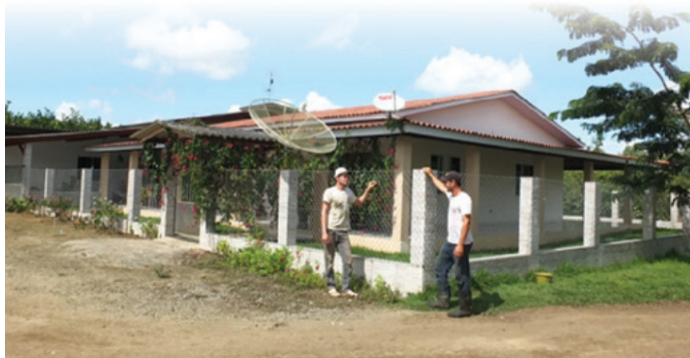
Residências rurais são construídas pelos produtores para o conforto da família e trabalhadores
