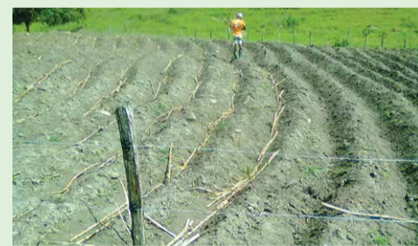
Implantação manual de capineira e canal de sequeiro – Fazenda União
