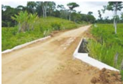
Estrada vicinal melhorada Aspecto de estrada vicinal feita pela Prefeitura Municipal com a construção de obra de arte localizada na área de ação do projeto Barro Preto.
