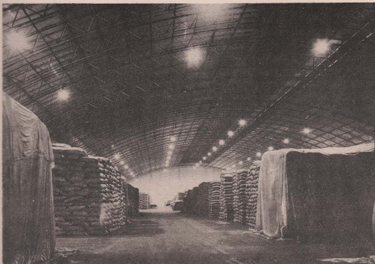
Figura 4 — Interior de armazém portuário de cacau. Note-se a profusão de elementos da estrutura, praticamente inacessíveis à aplicação de medidas higiénicas e profiláticas. Porto do Malhado, Ilhéus.
