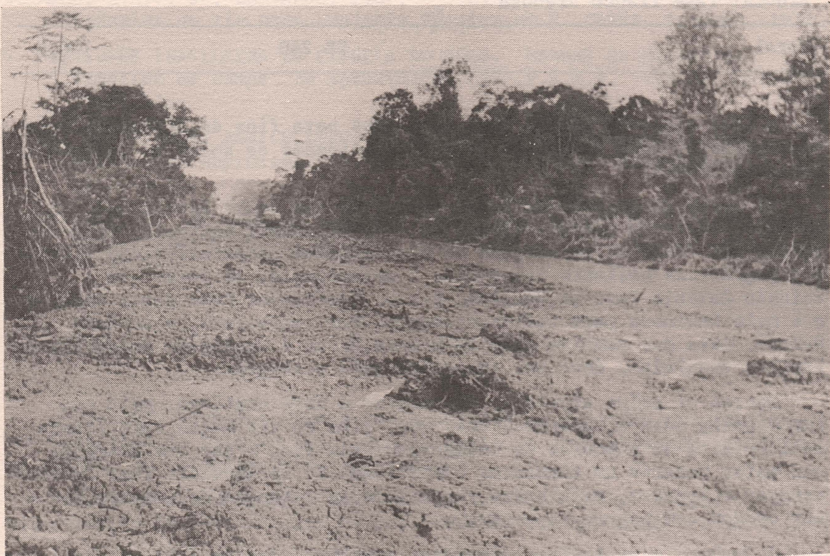
Figura 6 - Início dos trabalhos de drenagem do Vale Verde.
