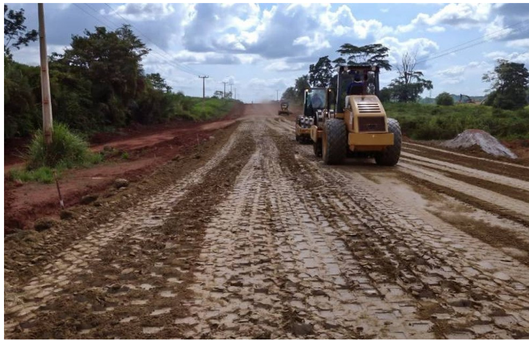
Pavimentação da BR-230/PA
