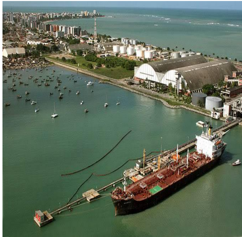
Terminal de Açúcar Maceió/AL
