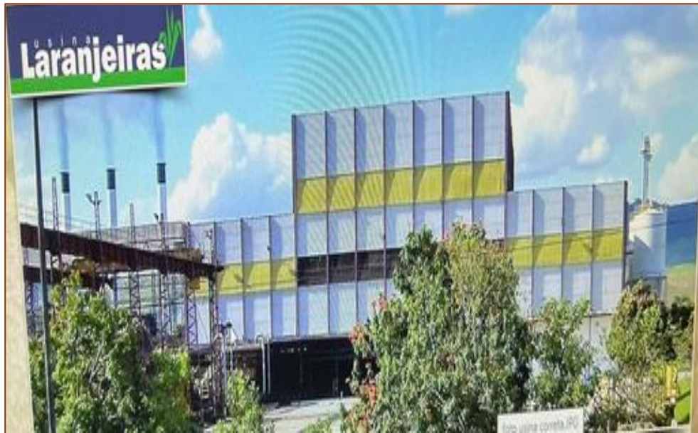
Usina Laranjeiras - Usivale
