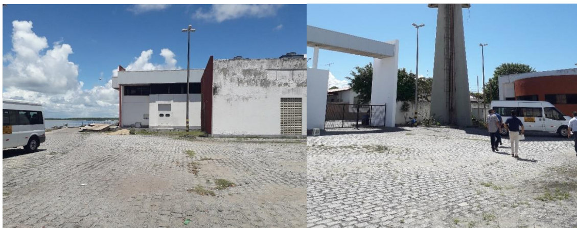
Figura 43: Fotos do pátio de manobras Fotos: Pier 3 (2019)
