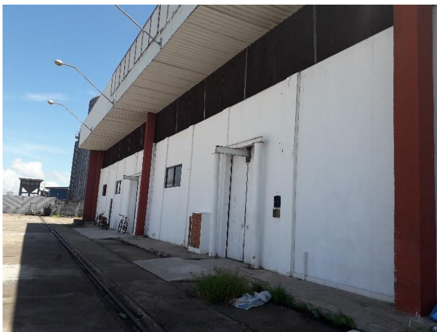
Figura 28: Fachada do Bloco Industrial (Entrepasto) na plataforma do Cais do TPP/Cabedelo Foto: Pier 3 (2019)
