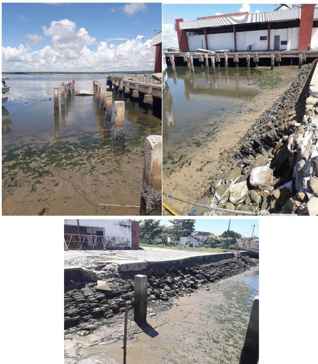
Figura 25: Fotos da área para Cais flutuante Foto: Pier 3 (2019)
