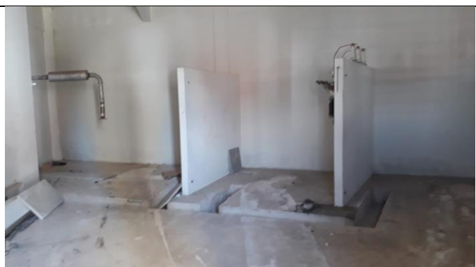
002 – SUBSTAÇÃO DE ENERGIA
