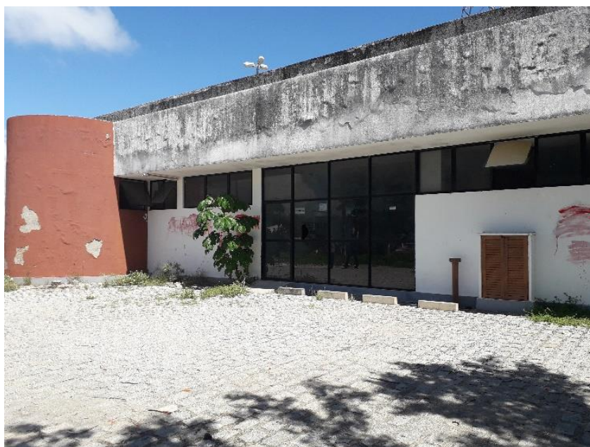
Figura 27: Fachada do Bloco Administrativo Foto: Píer 3 (2019)
