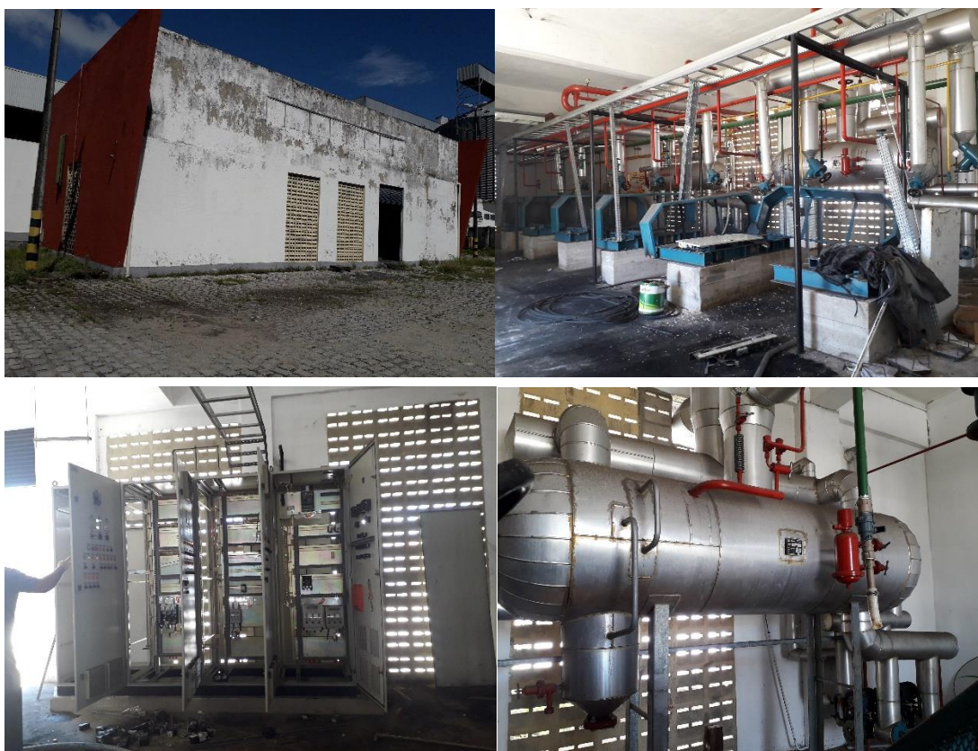
Figura 39: Fotos Casa de Máquinas Fotos: Píer 3 (2019)
