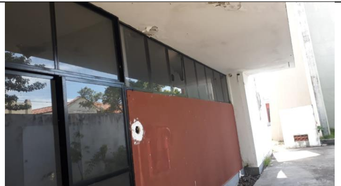
012 – ENTRADA BLOCO ADMINISTRATIVO
