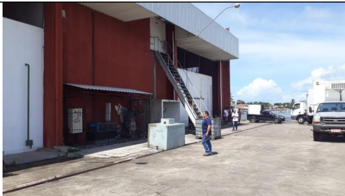
009 –CAIS LATERAL ENTREPOSTO
