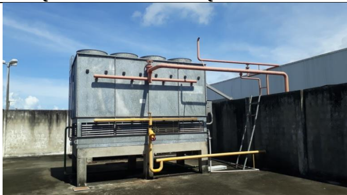
027 – CONDENSADOR EVAPORATIVO
