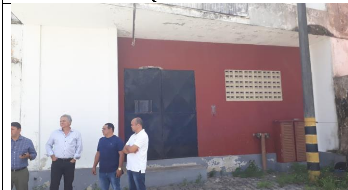
003 – SUBSTAÇÃO DE ENERGIA EXTERNO
