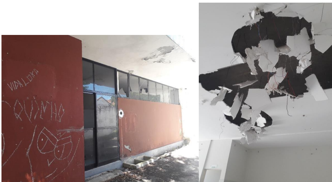
Figura 26: Fotos Bloco Administrativo Foto: Píer 3 (2019)
