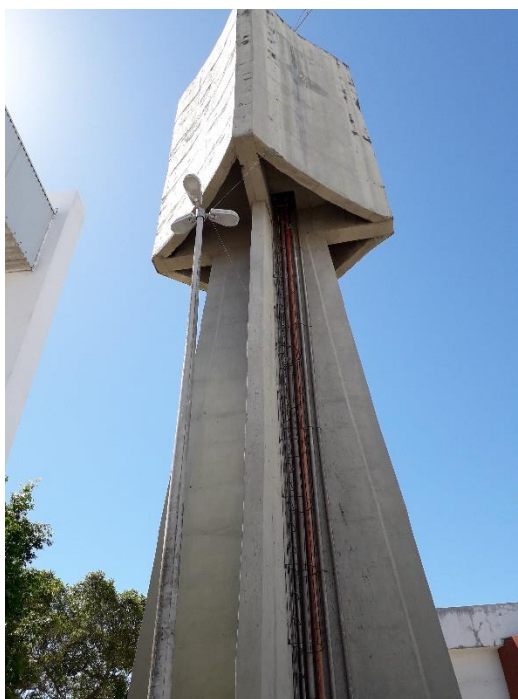
Figura 41: Reservatório de água Fotos: Píer 3 (2019)
