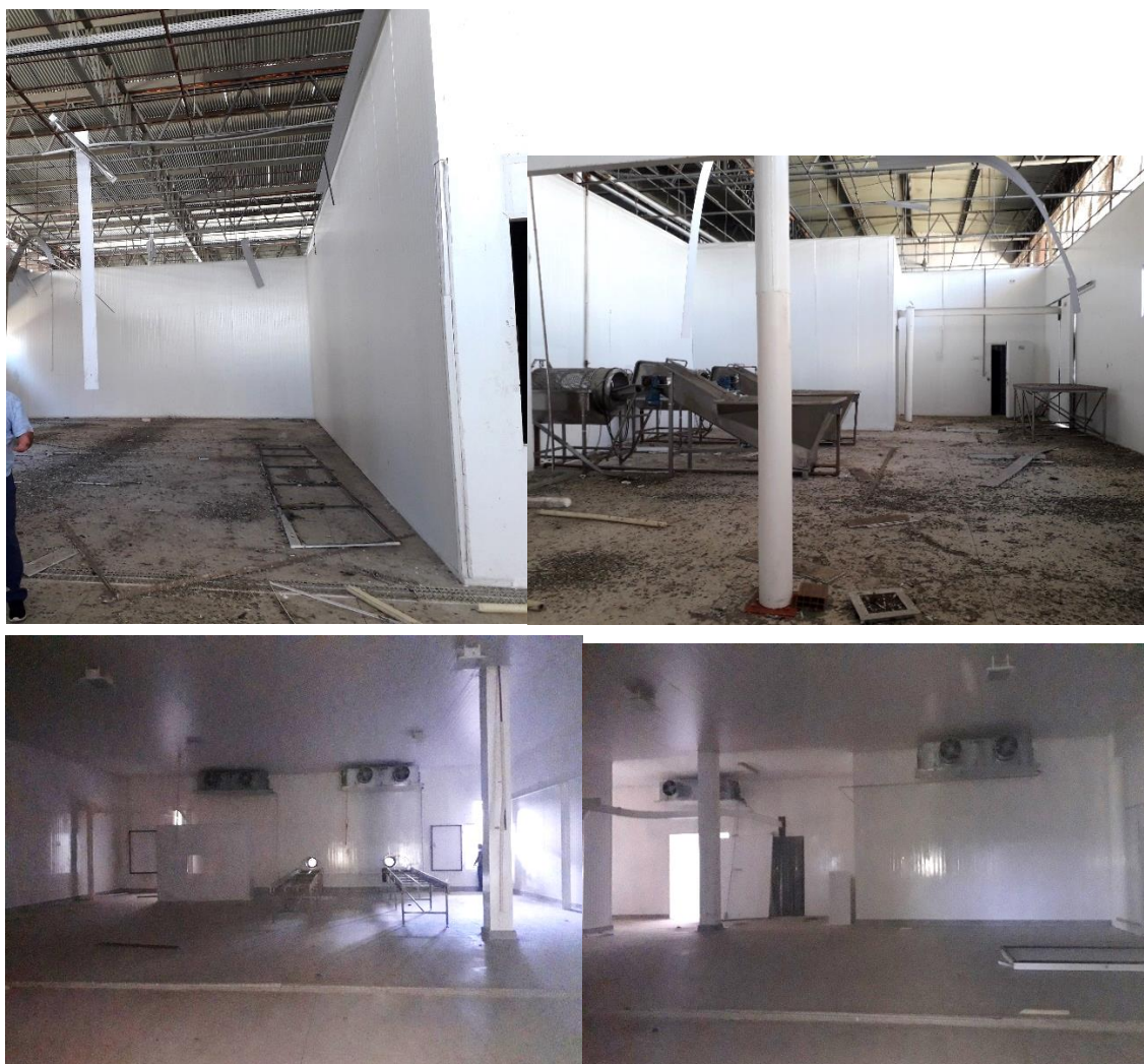
Figura 30: Fotos do Centro de Manipulação do Entrepósito TPP/Cabedelo Foto: Píer 3 (2019)
