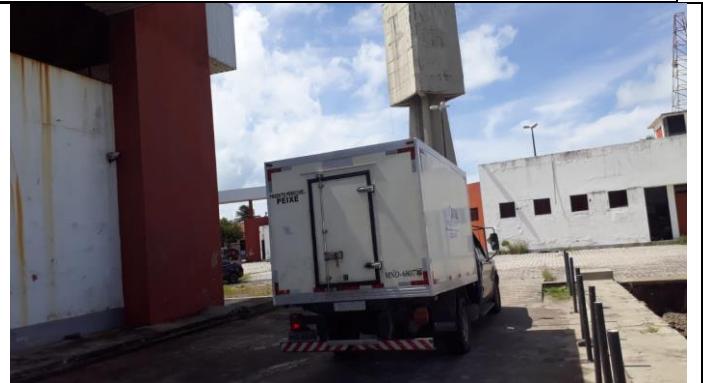
008 – LATERAL DO ENTREPOSTO
