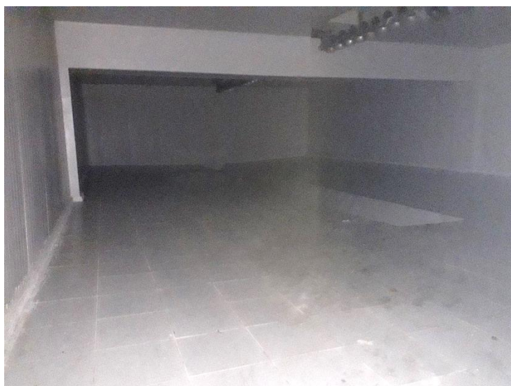
Figura 37: Armazenamento de gelo e rosca helicoidal Foto: Pier 3 (2019)
