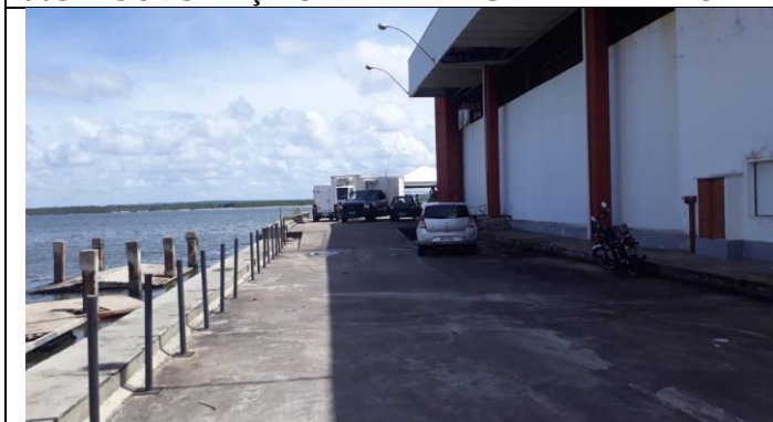
005 – LATERAL DO ENTREPOSTO
