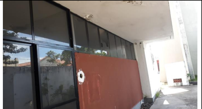
012 – ENTRADA BLOCO ADMINISTRATIVO
