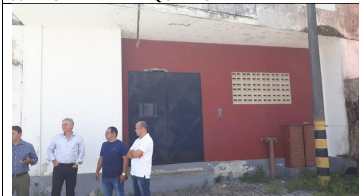
003 – SUBSTAÇÃO DE ENERGIA EXTERNO
