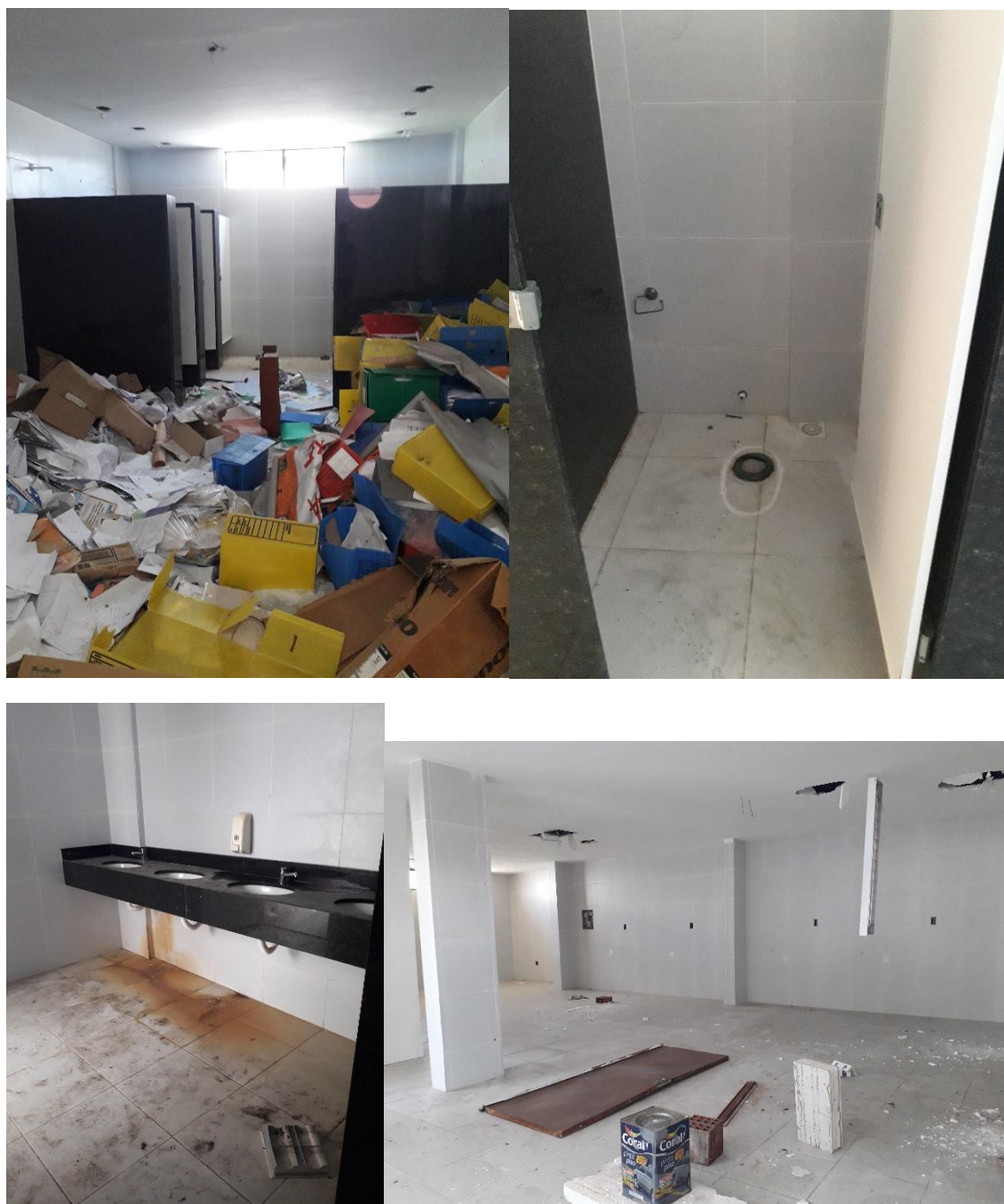
Figura 39: Fotos do Bloco Vestiário / Refeitório Fotos: Píer 3 (2019)
