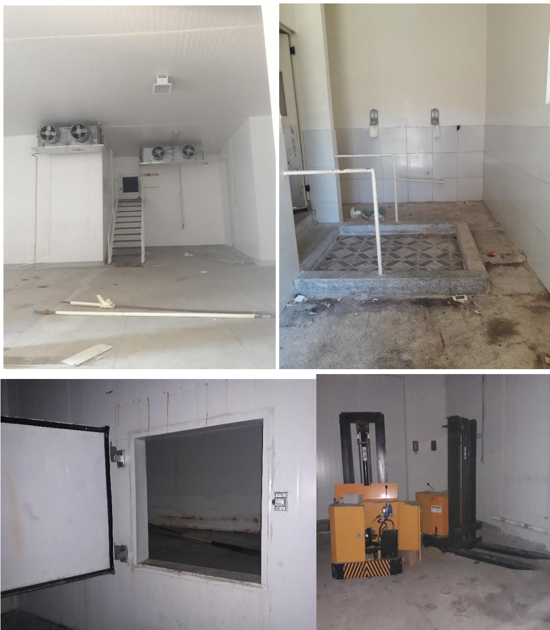
Figura 38: Fotos de detalhes do entreposto TPP/Cabedelo Fotos: Píer 3 (2019)
