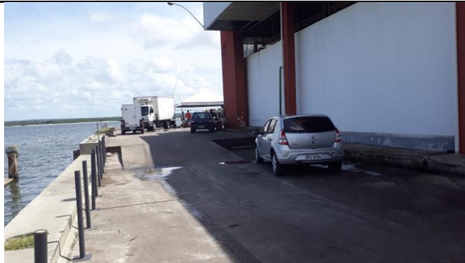
007 – LATERAL DO ENTREPOSTO
