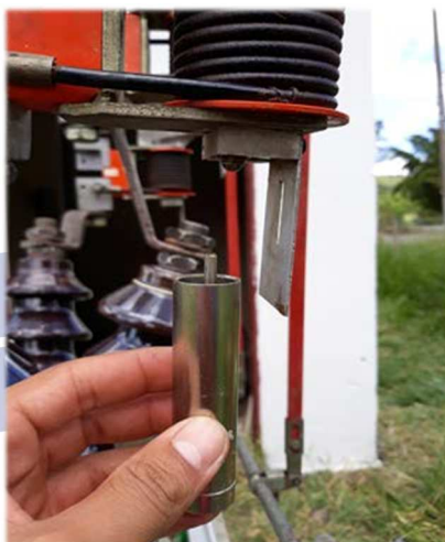
MANUTENÇÃO PREVENTIVA NO DISJUNTOR GERAL DE MÉDIA TENSÃO
