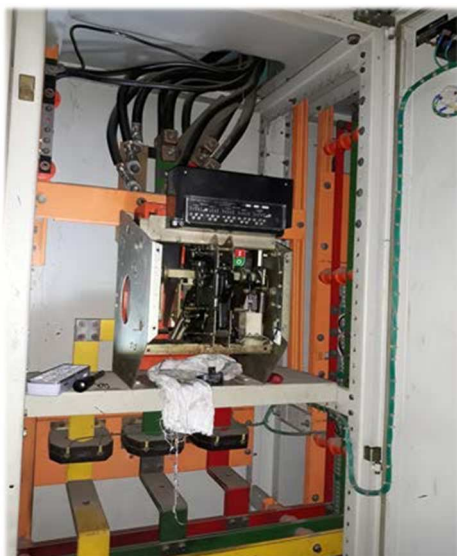
MANUTENÇÃO PREVENTIVA E CORRETIVA NO DISJUNTOR GERAL DO SISTEMA DE AR CONDICIONADO
