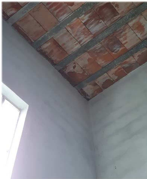
LAJE DA CABINE COM PONTOS DE INFILTRAÇÃO
