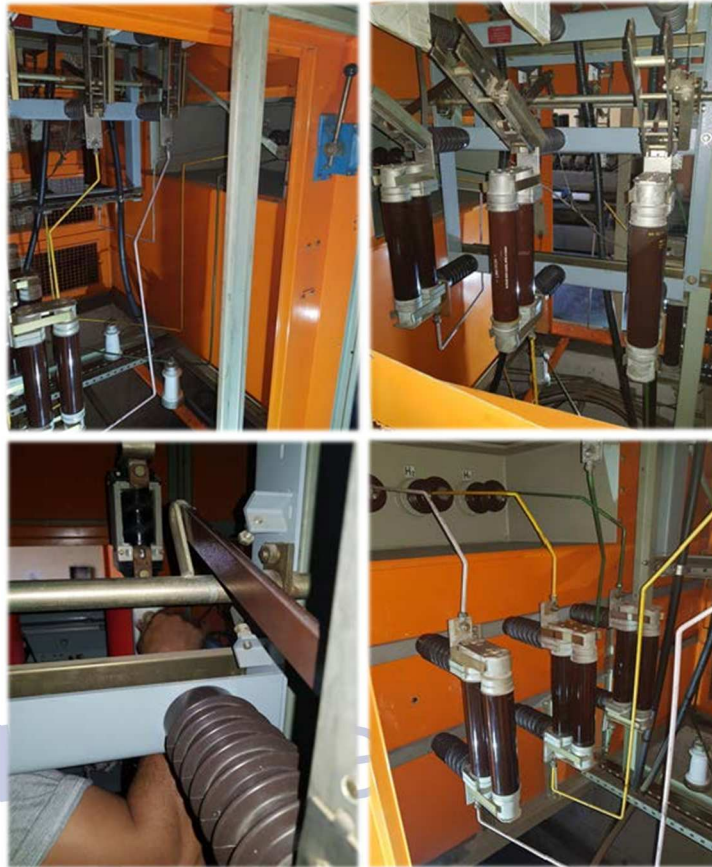
MANUTENÇÃO PREVENTIVA E AJUSTES DAS CHAVES SECCIONADORAS
