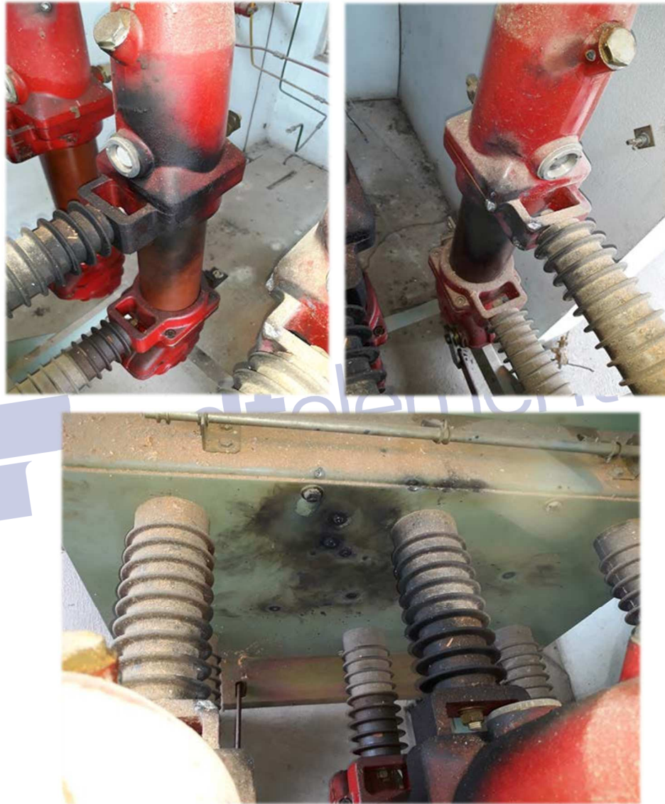
DISJUNTOR GERAL DE MÉDIA TENSÃO EM ESTADO PRECÁRIO DE CONSERVAÇÃO
