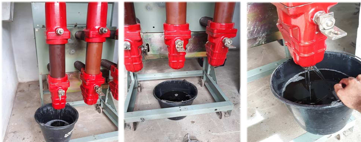
SUBSTITUIÇÃO DO ÓLEO ISOLANTE DOS PÓLOS DO DISJUNTOR
