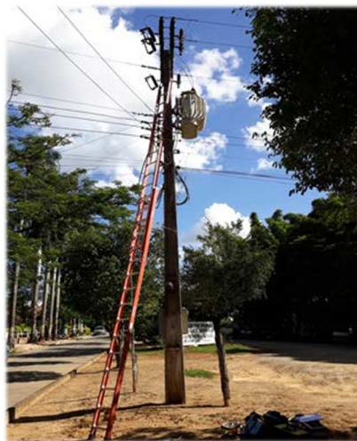
TRANSFORMADOR AÉREO
