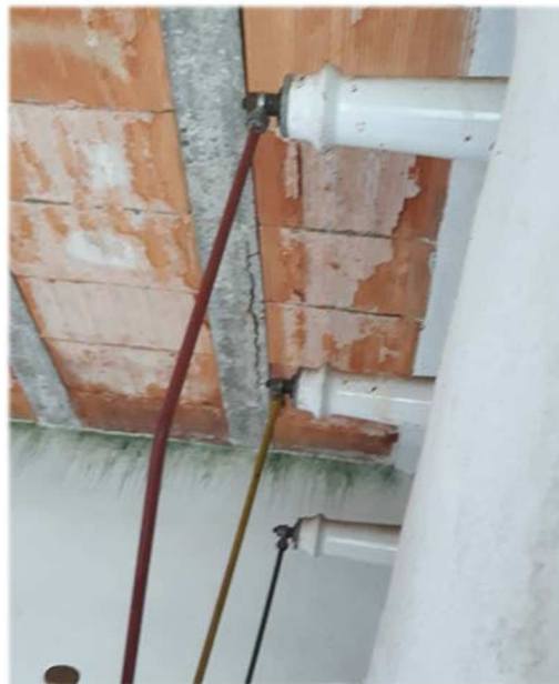
LAJE DA CABINE COM PONTOS DE INFILTRAÇÃO
