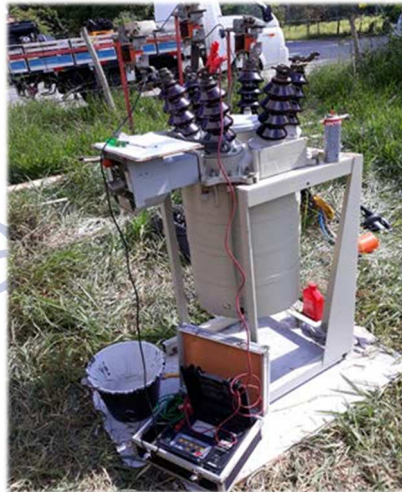
MANUTENÇÃO PREVENTIVA NO DISJUNTOR GERAL DE MÉDIA TENSÃO
