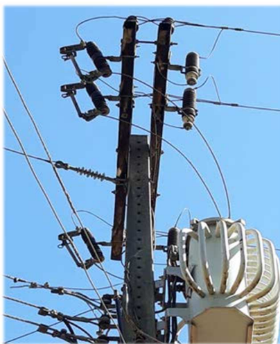
TRANSFORMADOR AÉREO
