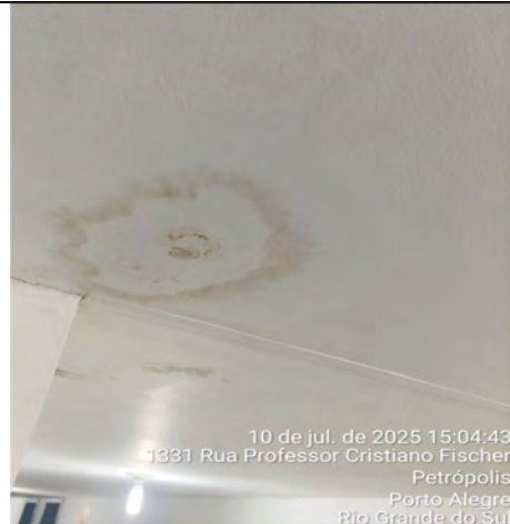
Imagem 120– Pintura do teto apresenta manchas causadas por infiltrações provenientes da cobertura
