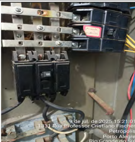
Imagem 89 – Quadro geral com estrutura em madeira antiga, com componentes em desacordo com as normas técnicas vigentes
