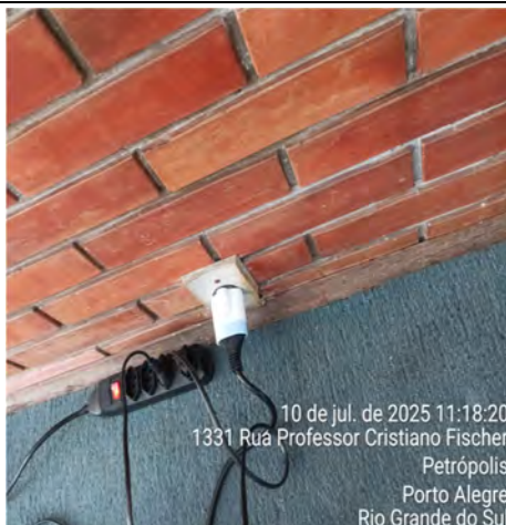
Imagem 77 – Utilização de extensões podendo ter sobrecarga elétrica e solta sob o carpete
