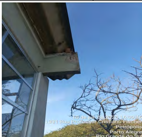
Imagem 255 – Vigas da fachada com armadura exposta
