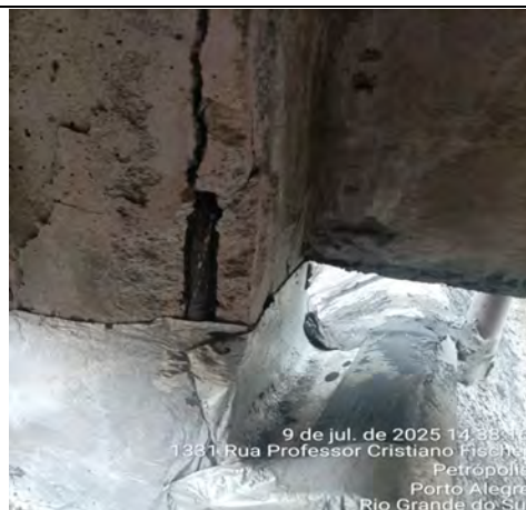
Imagem 230 – Verificou-se a exposição das armaduras dos pilares, com sinais de oxidação e perda do cobrimento de concreto, comprometendo a proteção e a resistência da estrutura
