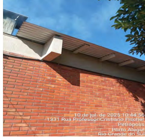
Imagem 224 – Manchas em diversas áreas do revestimento, decorrentes da ação das intempéries, acúmulo de sujeira, presença de fungos e desgaste natural da superfície
