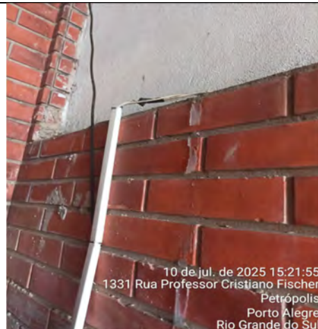
Imagem 40 – Fiação exposta e canaletas quebradas
