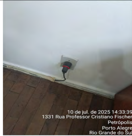
Imagem 54– Utilização de extensões podendo ter sobrecarga
