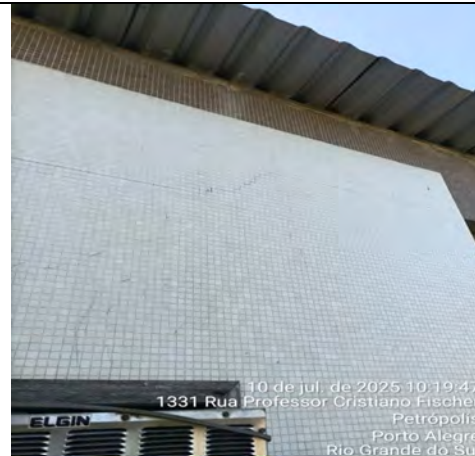
Imagem 216 – Existência de trincas e fissuras no revestimento da fachada
