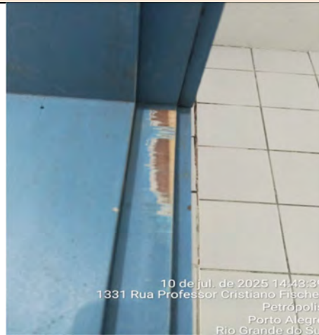
Imagem 92 – Portas com dificuldade de fechamento devido ao estufamento dos portais
