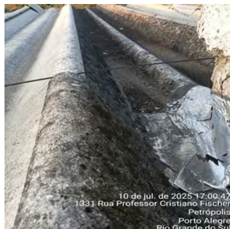
Imagem 2 – Telha Kalhetão emendada com manta
