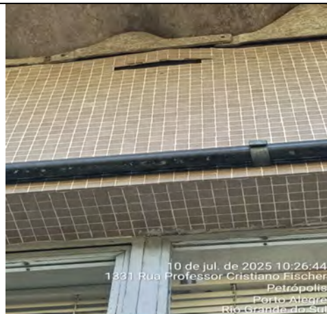
Imagem 222 – Deslocamento do reboco e das pastilhas e áreas pontuais
