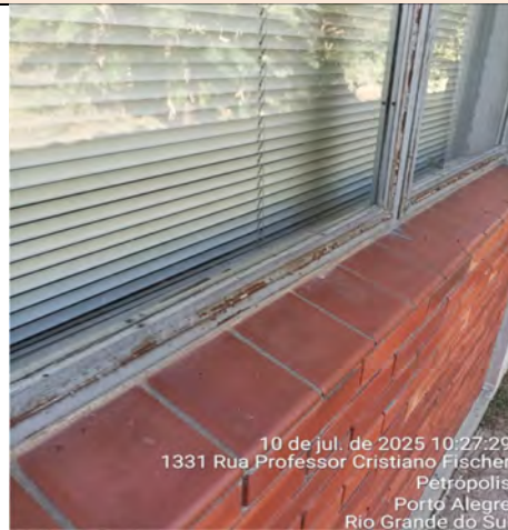
Imagem 104 – Esquadrias com pintura queimada e presença de oxidação
