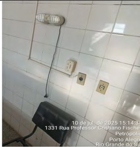
Imagem 44 – Tomadas fora do padrão e norma NBR 14136
