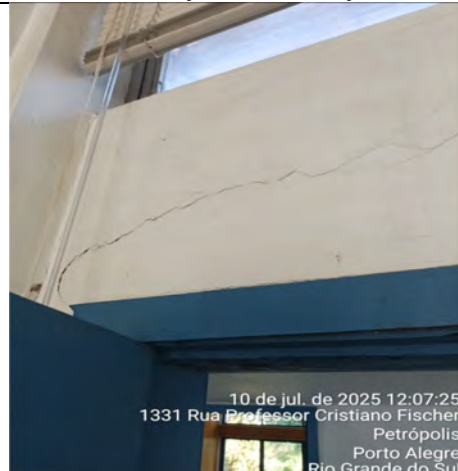
Imagem 136 – Trinca na parede possivelmente ocasionada pela ausência de verga e/ou contraverga, resultando em tensões concentradas nas alvenarias junto às aberturas
