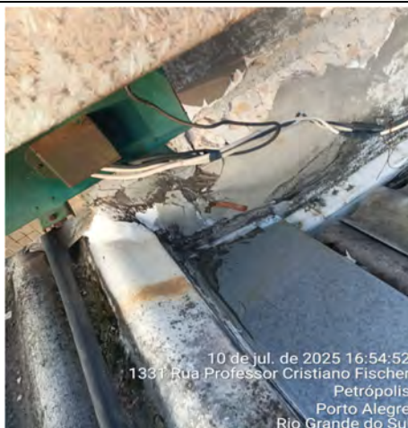
Imagem 27 – Fiação exposta na cobertura
