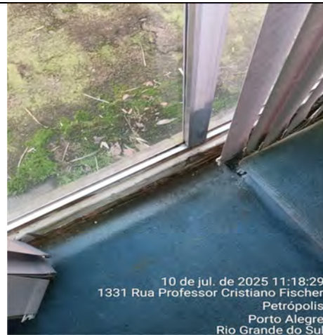
Imagem 102 – Esquadrias de alumínio com presença de lodo e ausência de vedação adequada
