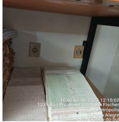
Imagem 68– Tomadas fora do padrão e norma NBR 14136
