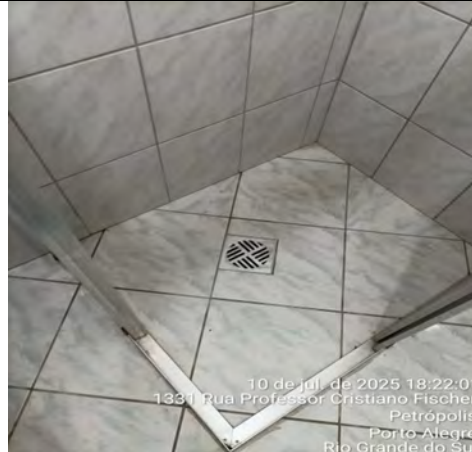
Imagem 192 – Tampa do ralo ressecado, comprometendo a integridade e a vedação da estrutura
