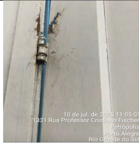
Imagem 100 – Algumas portas com as dobradiças danificadas
