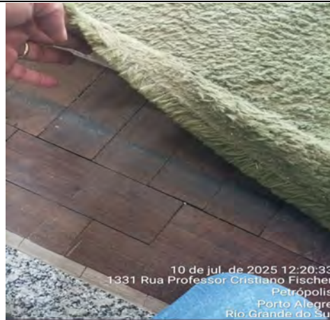
Imagem 156 – Em algumas salas, foram colocados tapetes como medida paliativa para mitigar riscos de acidentes em áreas onde há ausência de peças do piso de taco
