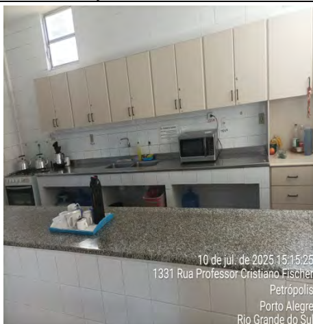
Imagem 179 – Revestimento cerâmico em bom estado, com necessidade de manutenção do rejunte, substituições de peças pontuais
