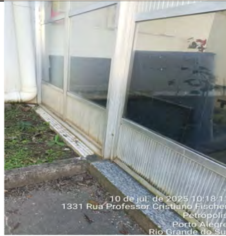
Imagem 110 – Esquadrias de alumínio com acúmulo excessivo de sujeira e ausência de vedação
