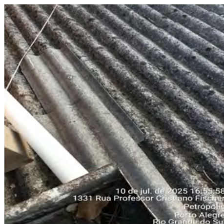
Imagem 16 – Telhas onduladas quebradas
