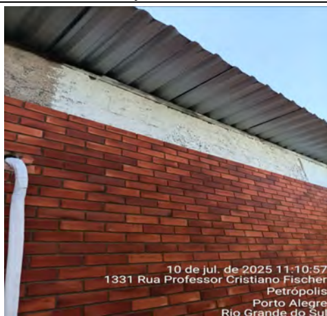
Imagem 215 – Áreas pontuais com ausência do revestimento (pastilhas)
