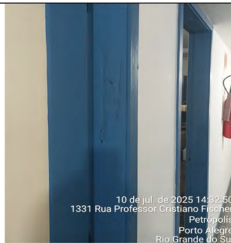
Imagem 94 – Portal com apodrecimento decorrente de ataque de cupim, comprometimento da integridade estrutural
