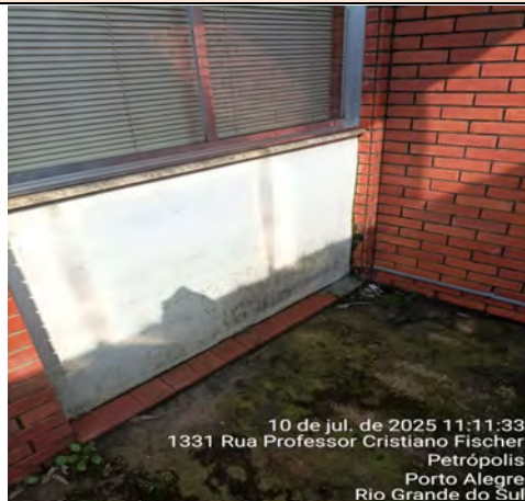
Imagem 218 – Pintura envelhecida e com presença de mofo
