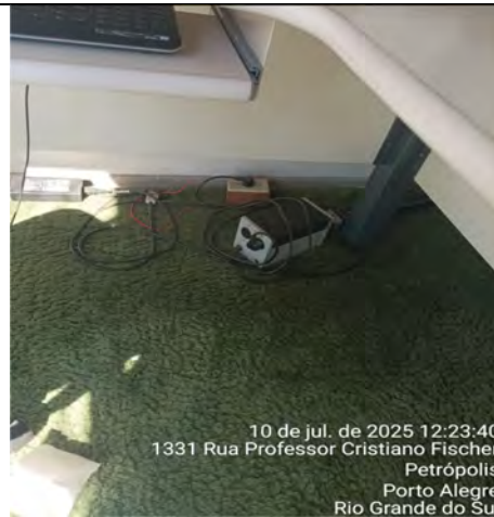
Imagem 66– Cabos elétricos e tomada expostos sob o carpete
