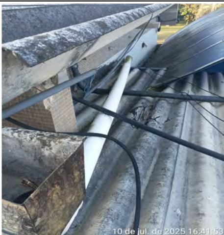
Imagem 33 – Eletroduto passando pela cobertura com sinais de desgaste
