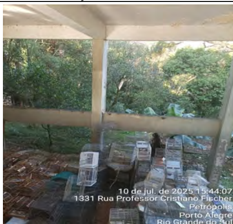
Imagem 247 – Verificou-se que a pintura da laje, dos pilares e das vigas da edificação apresenta diversos pontos de deterioração, caracterizados por descascamento, desbotamento, manchas e perda de aderência da película de tinta
