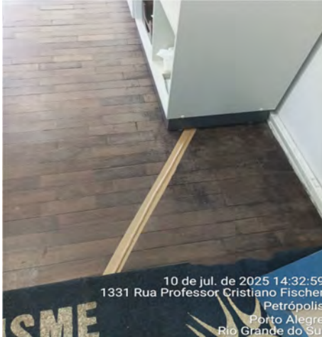
Imagem 55– Fiação passando sob o piso
