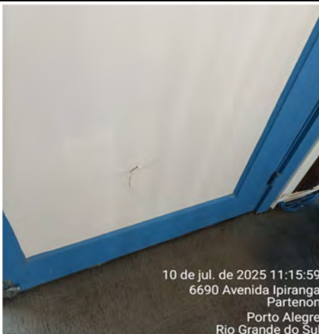
Imagem 99 – Portas danificadas com revestimento laminado quebrado
