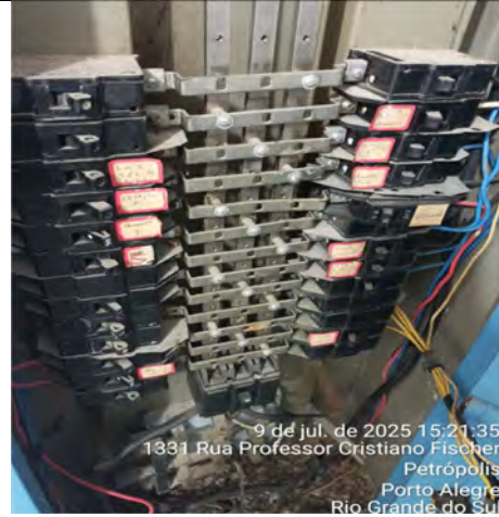
Imagem 88 – Quadro geral com estrutura em madeira antiga, com componentes em desacordo com as normas técnicas vigentes
