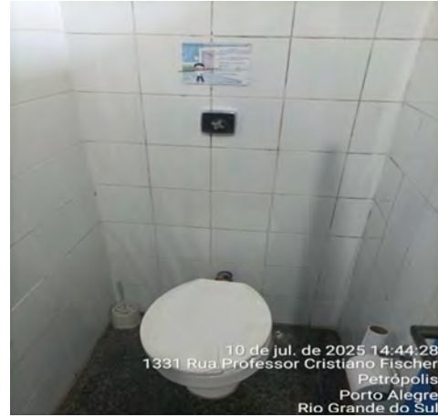
Imagem 184 – Válvula de descarga com ausência do acabamento de acionamento e presença de vazamento
