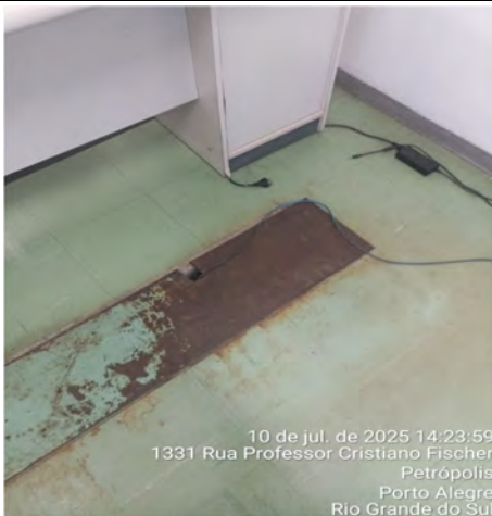
Imagem 57– Tampas metálicas das calhas de piso apresentam pontos de oxidação (ferrugem).
