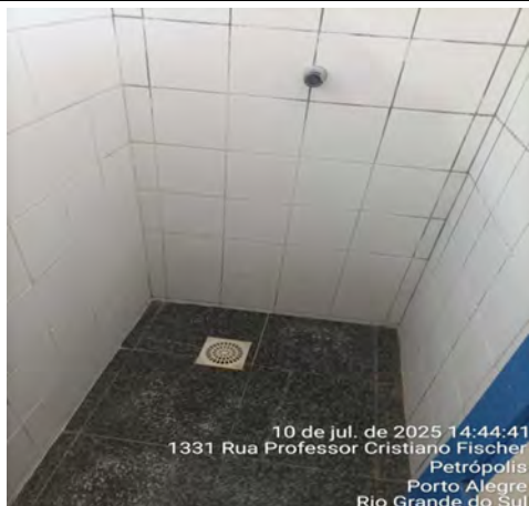
Imagem 191 – Tampa do ralo ressecado, comprometendo a integridade e a vedação da estrutura
