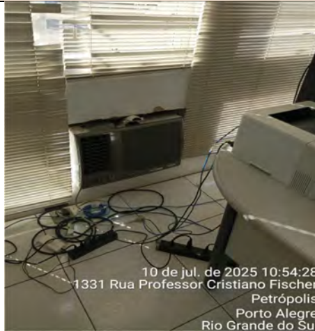
Imagem 80– Utilização de extensões podendo ter sobrecarga elétrica e solta sob o piso
