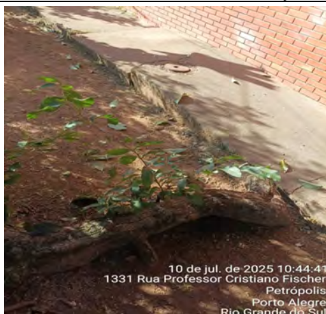
Imagem 167 – Calçadas danificadas devido ao levantamento e fissuração provocados pelo crescimento das raízes das árvores
