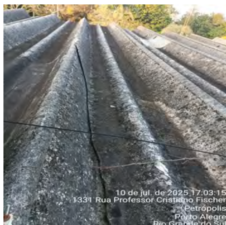
Imagem 1 – Telha Kalhetão quebrada
