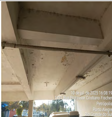
Imagem 241 – Pintura da laje do térreo da garagem com descascamentos, deslocamentos e manchas diversas
