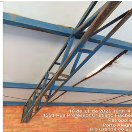
Imagem 22 – Estruturas metálicas da cobertura posterior com pintura comprometida e ferrugem em alguns elementos estruturais da cobertura
