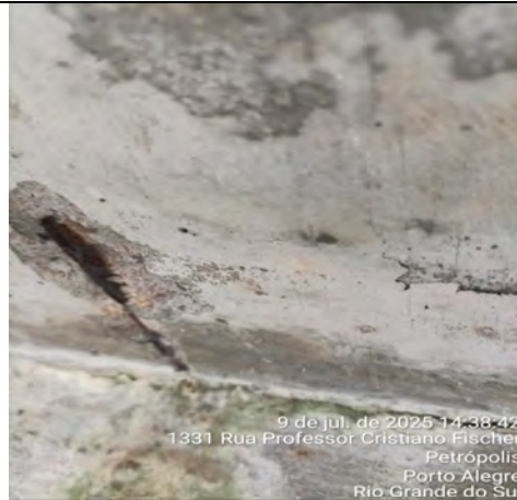
Imagem 232 – Exposição da ferragem da laje e com sinais de oxidação
