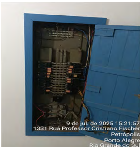
Imagem 87 – Quadro geral com estrutura em madeira antiga, com componentes em desacordo com as normas técnicas vigentes
