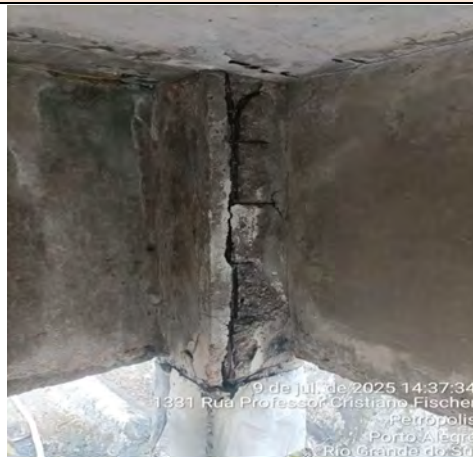
Imagem 228 – Verificou-se a exposição das armaduras dos pilares, com sinais de oxidação e perda do cobrimento de concreto, comprometendo a proteção e a resistência da estrutura
