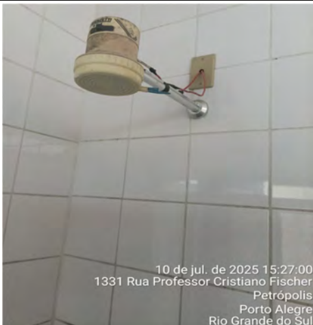
Imagem 35 – Chuveiros antigo e emenda dos cabos próximo ao braço do chuveiro
