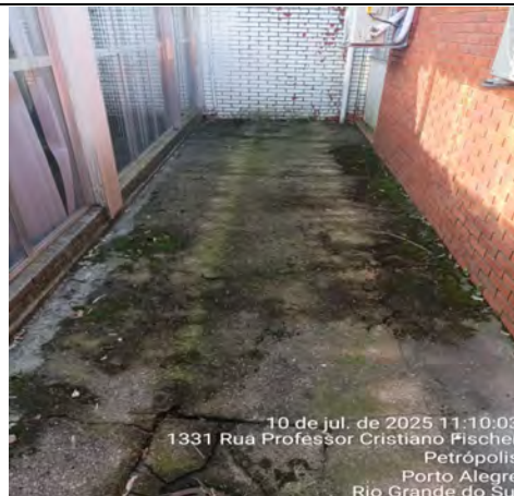
Imagem 166 – Piso da área de ventilação do auditório danificado e trincado, requerendo substituição total
