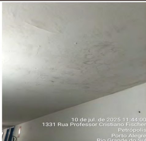
Imagem 133 – Infiltrações no teto com comprometimento da pintura, decorrentes da perda de impermeabilização da cobertura, ocasionando manchas
