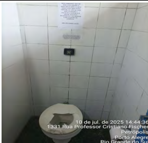
Imagem 185 – Válvula de descarga com ausência do acabamento de acionamento e presença de vazamento, além de tampa do vaso sanitário quebrada, comprometendo a funcionalidade e as condições de uso do equipamento
