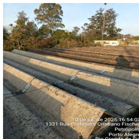
Imagem 4 - Telha Kalhetão quebradas e emendadas com manta
