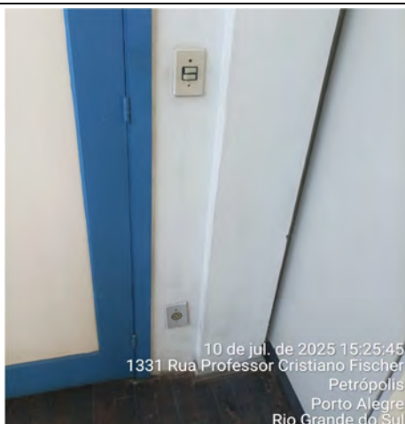
Imagem 39 – Tomadas fora do padrão e norma NBR 14136
