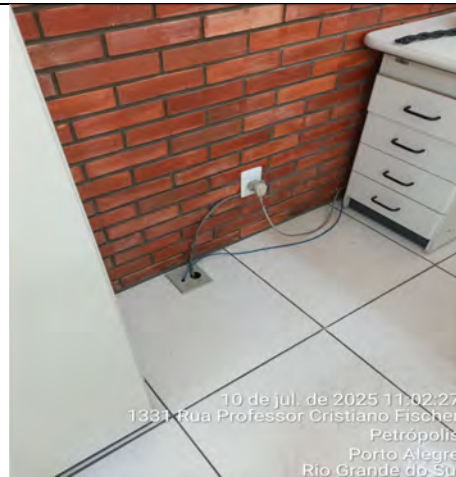
Imagem 82– Tomadas embutidas no piso sem vedação e fora do padrão e norma NBR 14136
