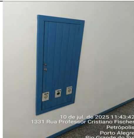
Imagem 76 – Quadro elétrico interno instalado no corredor central e com estrutura em madeira
