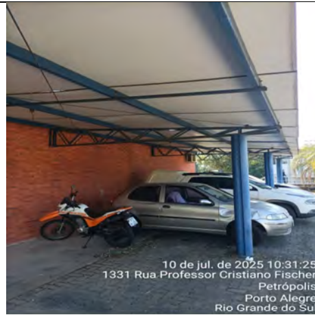
Imagem 24 – Estruturas e cobertura do estacionamento posterior com necessidade de substituição do telhamento e revitalização das estruturas
