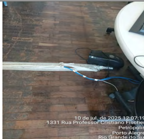
Imagem 154 – O piso de taco em madeira apresenta desgaste generalizado, com peças soltas em áreas pontuais e superfície do revestimento desbotada
