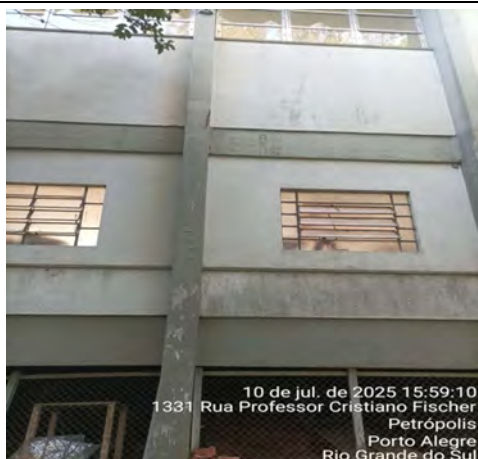
Imagem 249 – Paredes e elementos estruturais da fachada com pintura em péssimo estado de conservação
