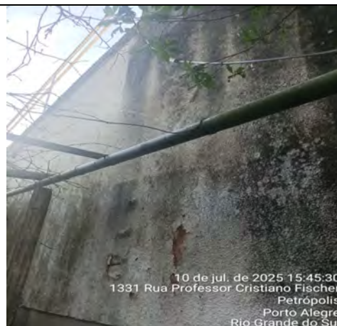
Imagem 248 – Pintura das fachadas com existência de lodo em algumas áreas
