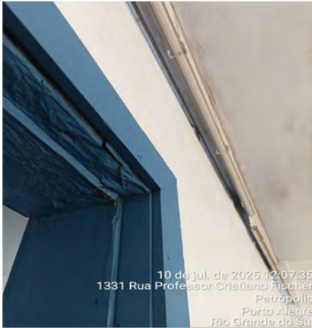
Imagem 97 – Portal com apodrecimento decorrente de ataque de cupim, comprometimento da integridade estrutural
