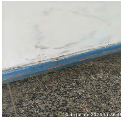
Imagem 174 – Os rodapés de madeira encontram-se, em grande parte, danificados, com comprometimento da integridade estrutural e estética
