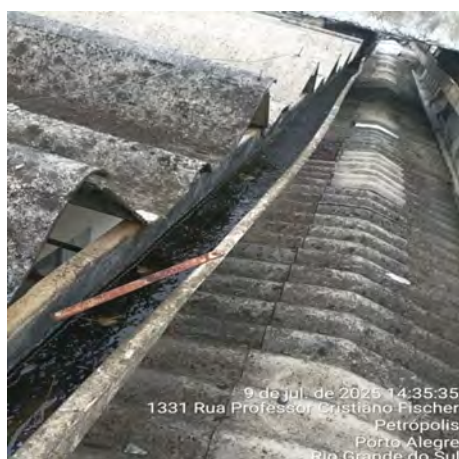
Imagem 11 – Calhas de fibra com perda de seção devido ao desgaste do material
