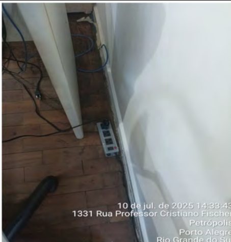
Imagem 53– Utilização de extensões podendo ter sobrecarga elétrica
