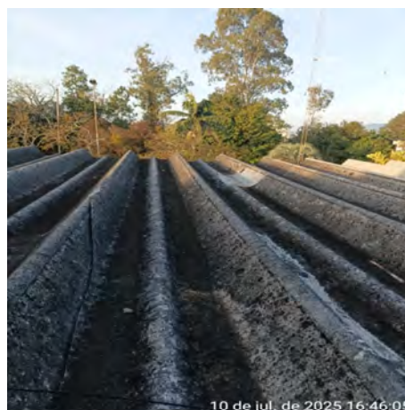
Imagem 8 – Telha Kalhetão quebradas e com formação de envergaduras e deformações ao longo dos eixos
