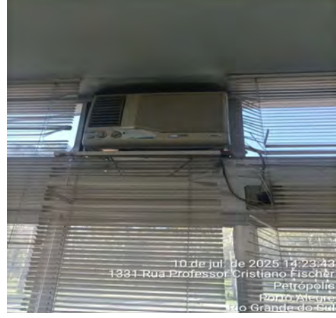
Imagem 200 – Ar condicionado de janela queimado e sem peça de reposição no mercado
