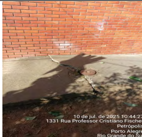
Imagem 168 – Calçadas danificadas devido ao levantamento e fissuração provocados pelo crescimento das raízes das árvores
