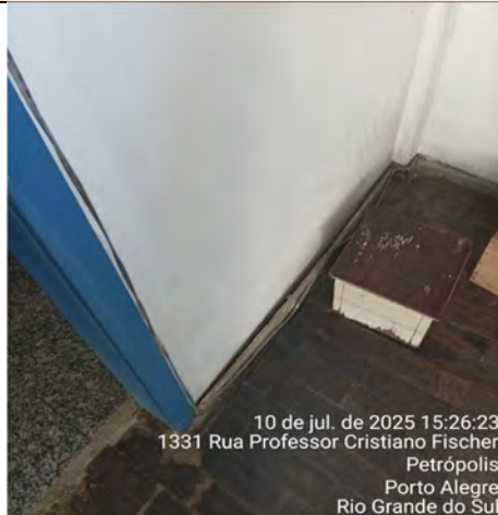
Imagem 38 – Fiação exposta passando pelo rodapé de madeira
