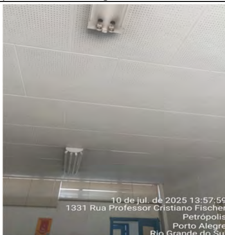
Imagem 137 – Placas de revestimento acústico coladas no teto, previstas para remoção em função da necessidade de adequações no ambiente
