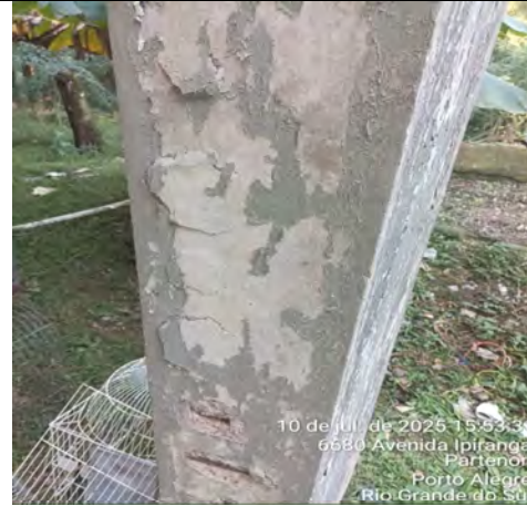
Imagem 244 – Pintura dos pilares com descascamentos e com a ferragem expostas em alguns pontos
