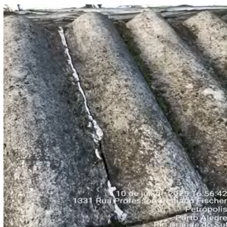
Imagem 17 – Telhas onduladas quebradas
