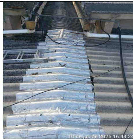
Imagem 30 – Fiação exposta na cobertura
