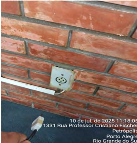
10 de jul. de 2025 11:18:05 1331 Rua Professor Cristiano Fischer Petrópolis Porto Alegre Rio Grande do Sul Imagem 127 – Pintura existente do revestimento em tijolinho apresenta descascamento
