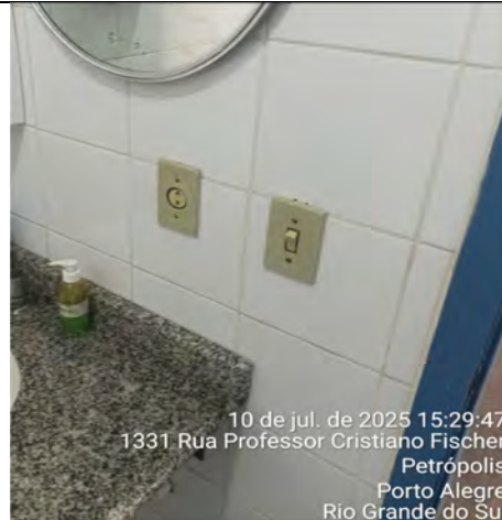
Imagem 34 – Tomadas fora do padrão e norma NBR 14136
