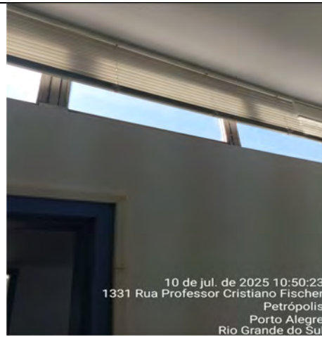
Imagem 112 – Basculante metálico com pintura queimada e com presença de oxidação
