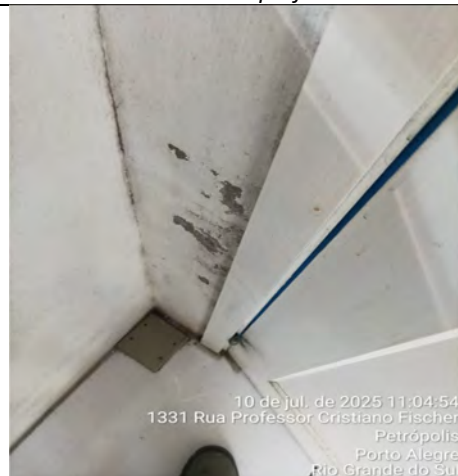
Imagem 124 – Paredes com pintura descascadas, apresentando falhas de aderência do revestimento de acabamento
