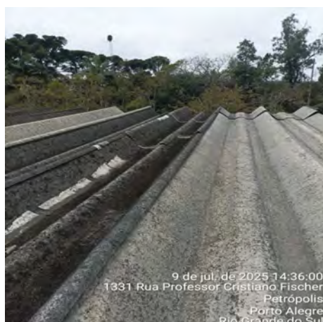
Imagem 3 - Telha Kalhetão quebradas e emendadas com manta
