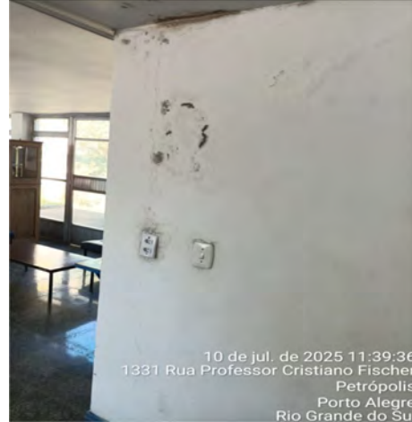
10 de jul. de 2025 11:39:36 1331 Rua Professor Cristiano Fischer Petrópolis Porto Alegre Rio Grande do Sul Imagem 132 – Manchas no teto e nas paredes decorrentes de infiltrações provenientes da cobertura e de tubos de queda de águas pluviais embutidos na parede
