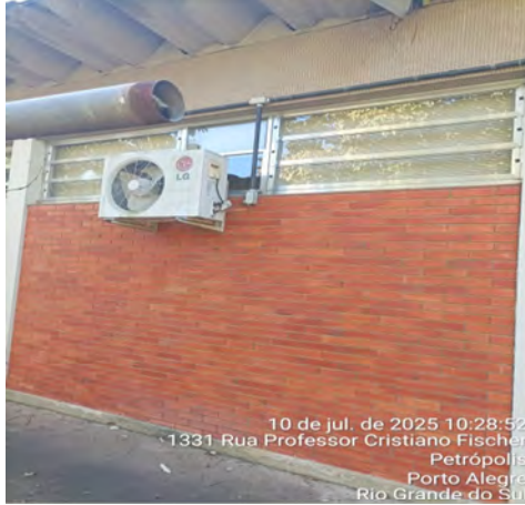
Imagem 223 – Manchas em diversas áreas do revestimento, decorrentes da ação das intempéries, acúmulo de sujeira, presença de fungos e desgaste natural da superfície
