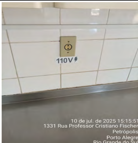
Imagem 43 – Tomadas fora do padrão e norma NBR 14136
