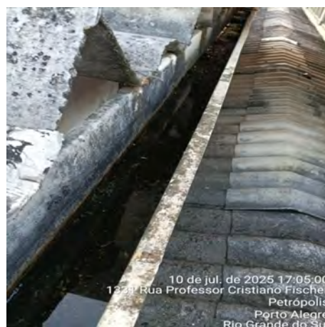
Imagem 10 – Acúmulo da água nas calhas devido o desnívelamento
