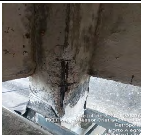
Imagem 229 – Verificou-se a exposição das armaduras dos pilares, com sinais de oxidação e perda do cobrimento de concreto, comprometendo a proteção e a resistência da estrutura
