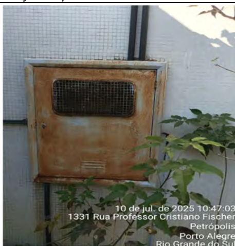
Imagem 83– Quadro elétrico instalado na parte externa, sem proteção adequada contra intempéries e com presença de oxidação (ferrugem) em sua estrutura, caracterizando condição de risco e desconformidade com os requisitos da NBR 5410.
