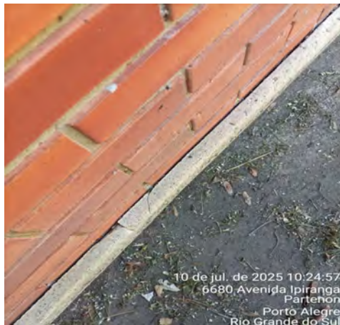
Imagem 211 – Rodapé de concreto solto
