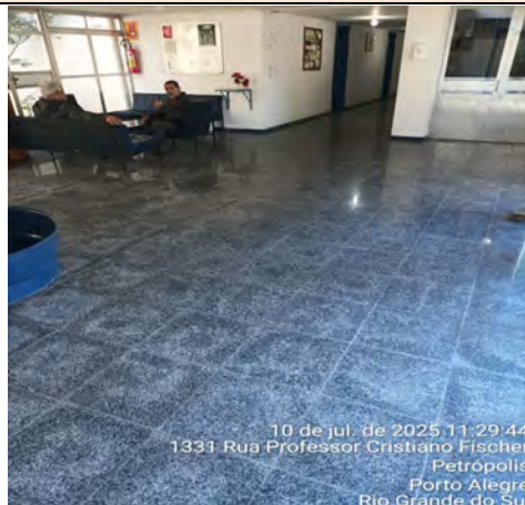
Imagem 140 – Piso de granito apresenta superfície desgastada, com perda de brilho e presença de manchas
