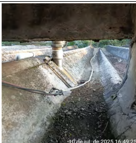
Imagem 29 – Fiação exposta na cobertura
