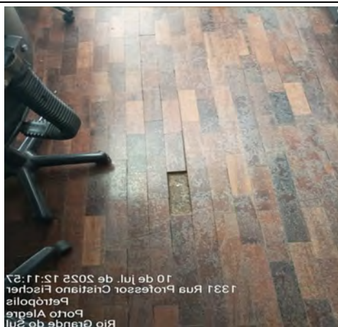
Imagem 151 – O piso de taco em madeira apresenta desgaste generalizado, com peças soltas em áreas pontuais e superfície do revestimento desbotada
