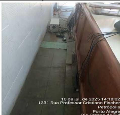
Imagem 159 – Salas com piso em paviflex antigo, danificado e com peças faltantes, demandando substituição do revestimento
