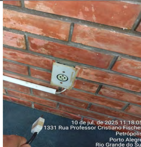
Imagem 78 – Tomadas fora do padrão e com fiação exposta
