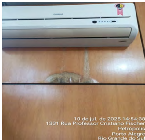
Imagem 201– Aparelho de ar-condicionado apresenta vazamento, possivelmente oriundo da bomba de dreno
