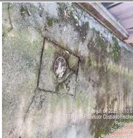
Imagem 163 – Piso da área de ventilação do auditório danificado e trincado, requerendo substituição total e reforma do sistema de captação de águas pluviais
