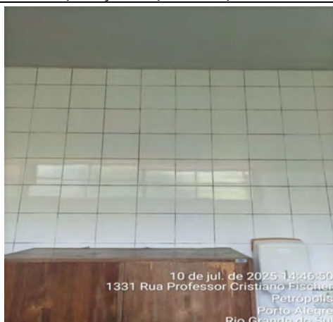
Imagem 177– Revestimento cerâmico em bom estado, com necessidade de manutenção do rejunte, substituições de peças pontuais e recomendação para aplicação de pintura epóxi
