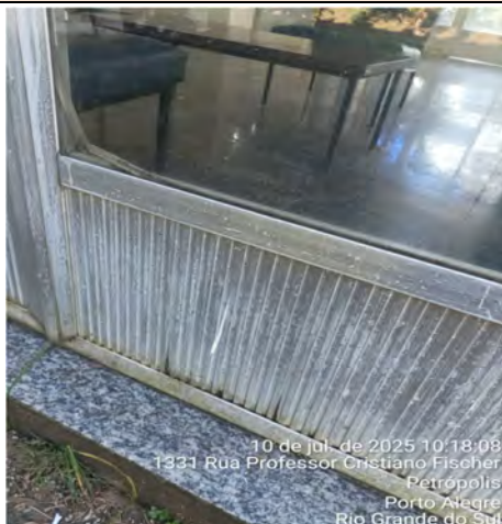
Imagem 109 – Esquadrias de alumínio com acúmulo excessivo de sujeira e ausência de vedação
