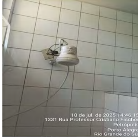
Imagem 176 – Revestimento cerâmico em bom estado, com necessidade de manutenção do rejunte, substituições de peças pontuais e recomendação para aplicação de pintura epóxi
