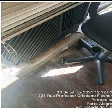
Imagem 195– Ar condicionado de janela queimado e sem peça de reposição no mercado
