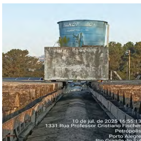
Imagem 9 – Desnívelamento das calhas de fibra
