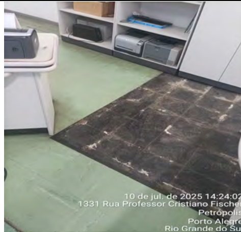
Imagem 162 – Salas com piso em paviflex antigo, danificado e com peças faltantes, demandando substituição do revestimento
