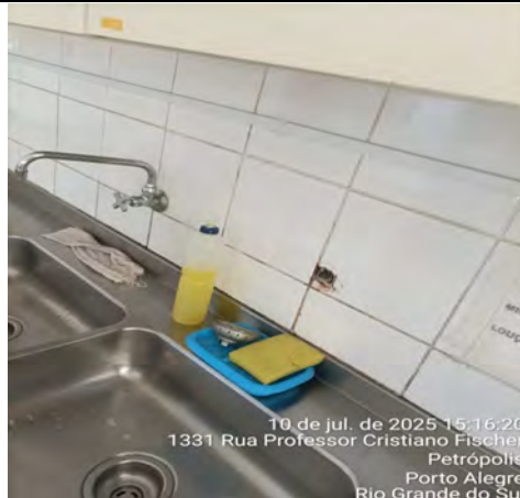
Imagem 188 – Pia da cozinha com ausência de torneira e Joelho de ligação danificado, comprometendo a funcionalidade do ponto hidráulico e demandando intervenção corretiva
