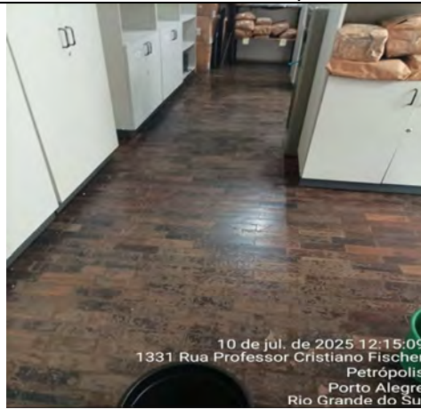
Imagem 152 – O piso de taco em madeira apresenta desgaste generalizado, com peças soltas em áreas pontuais e superfície do revestimento desbotada
