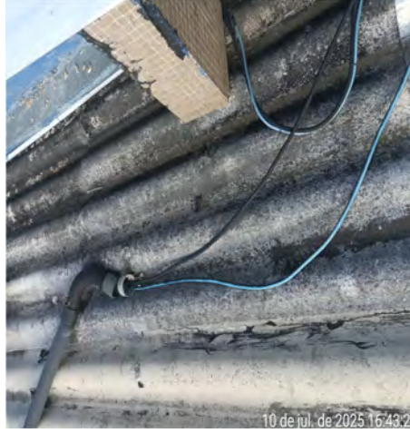
Imagem 32 – Eletroduto sem continuidade e fiação exposta
