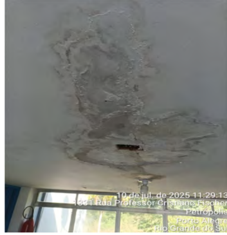
10 de jul. de 2025 11:29:13 1331 Rua Professor Cristiano Fischer Petrópolis Porto Alegre Rio Grande do Sul Imagem 128 – Infiltrações no teto com comprometimento da pintura, decorrentes da perda de impermeabilização da cobertura, ocasionando manchas, descascamento e degradação dos elementos de acabamento
