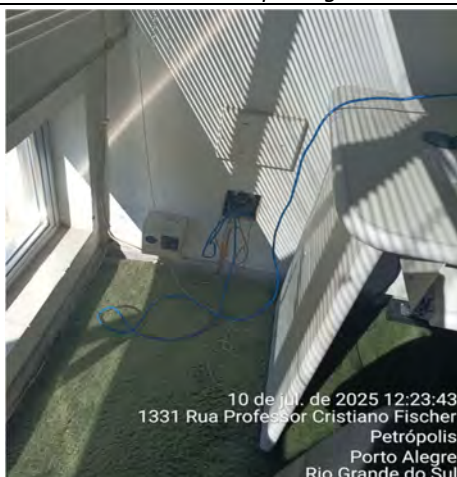
Imagem 65– Cabos de rede e elétrico expostos sob o piso
