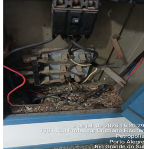
Imagem 90 – Quadro geral com estrutura em madeira antiga, com componentes em desacordo com as normas técnicas vigentes
