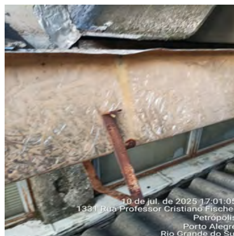
Imagem 12 – Suporte de sustentação das calhas soltos ou quebrados em vários pontos
