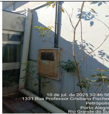
Imagem 84– Quadro elétrico instalado na parte externa, sem proteção adequada contra intempéries e com presença de oxidação (ferrugem) em sua estrutura, caracterizando condição de risco e desconformidade com os requisitos da NBR 5410.
