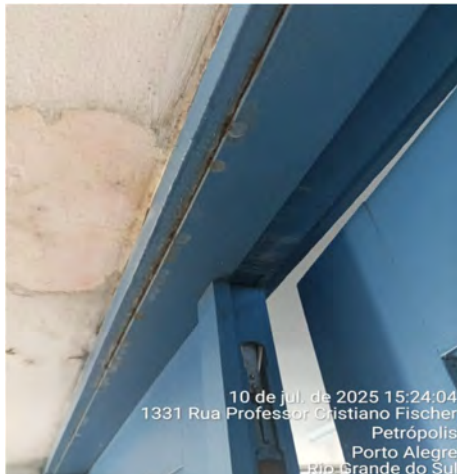
Imagem 91 – Portais e alisares com estufamento em decorrência do contato com infiltrações provenientes da cobertura
