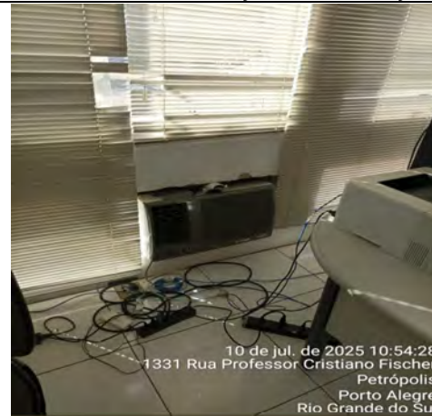
Imagem 196 – Ar condicionado de janela queimado e sem peça de reposição no mercado
