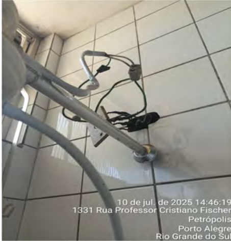
Imagem 49– Fiação expostas e tomadas danificadas
