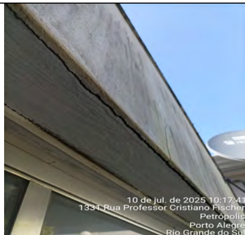
Imagem 220 – Deslocamento do reboco da fachada da marquise posterior
