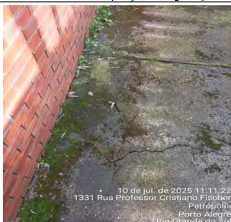
Imagem 165 – Piso da área de ventilação do auditório danificado e trincado, requerendo substituição total
