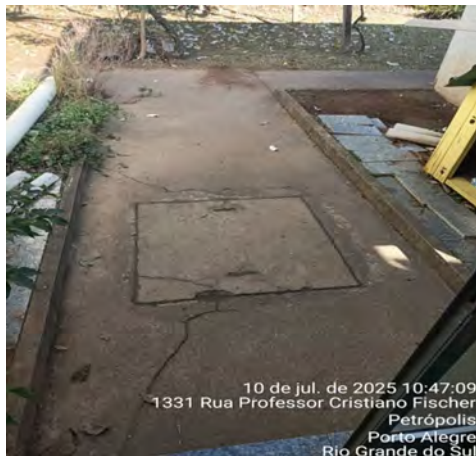
Imagem 169 – Calçadas externa da fachada posterior apresentando trincas localizadas em áreas pontuais
