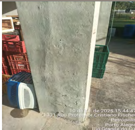
Imagem 246 – Pintura dos pilares com descascamentos
