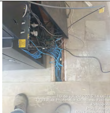
Imagem 64– Cabos de rede expostos sob o piso
