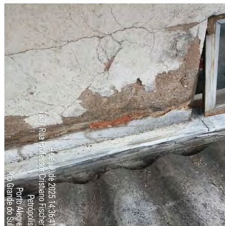
Imagem 18 – Calha metálica do rebaixo da cobertura instalada sem o rufo de proteção nas paredes e estruturas da edificação
