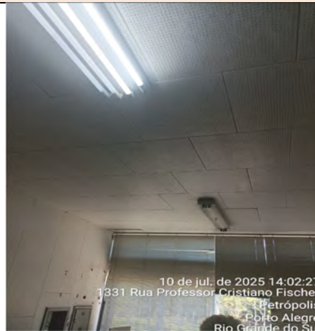
Imagem 62– Luminárias danificadas e lâmpadas queimadas
