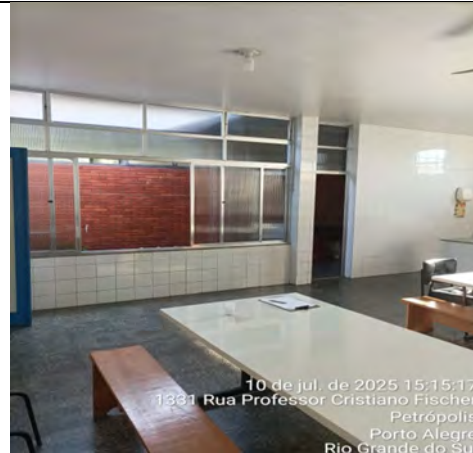
Imagem 180 – Revestimento cerâmico em bom estado, com necessidade de manutenção do rejunte, substituições de peças pontuais
