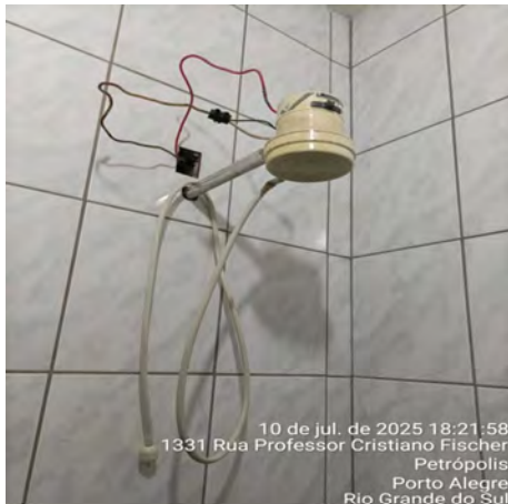
Imagem 175 - Revestimento cerâmico em bom estado, com necessidade de manutenção do rejunte, substituições de peças pontuais e recomendação para aplicação de pintura epóxi
