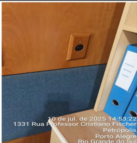
Imagem 47 – Tomadas fora do padrão e norma NBR 14136
