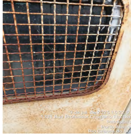
Imagem 86 – Quadro elétrico instalado na parte externa, sem proteção adequada contra intempéries e com presença de oxidação em sua estrutura, caracterizando condição de risco e desconformidade com os requisitos da NBR 5410.
