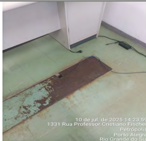
Imagem 160 – Salas com piso em paviflex antigo, danificado e com peças faltantes, demandando substituição do revestimento
