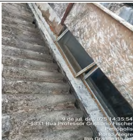
Imagem 111 – Basculante metálico com pintura queimada e com presença de oxidação
