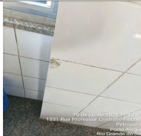
Imagem 178 – Revestimento cerâmico em bom estado, com necessidade de manutenção do rejunte, substituições de peças pontuais e recomendação para aplicação de pintura epóxi
