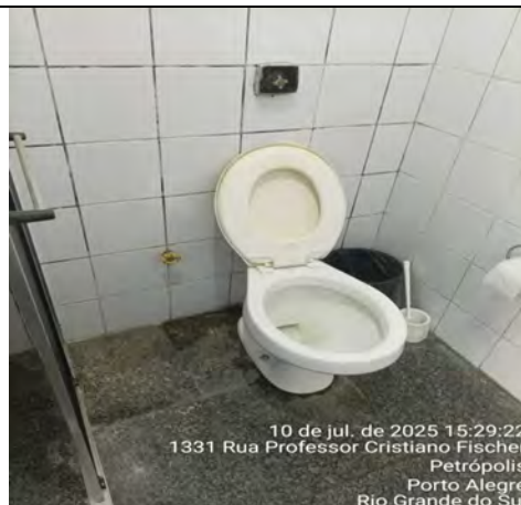
Imagem 190 – Válvula de descarga com ausência do acabamento de acionamento e presença de vazamento na base da bacia sanitária, causado pelo desgaste do anel de vedação, comprometendo a estanqueidade e a eficiência do sistema
