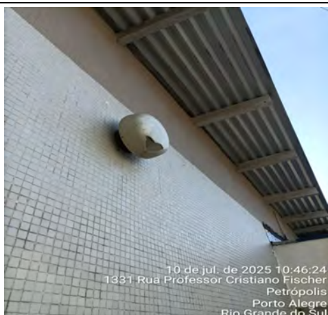
Imagem 219– Revestimento cerâmico em pastilhas apresenta manchas superficiais de coloração escurecida e degradação do rejuntamento
