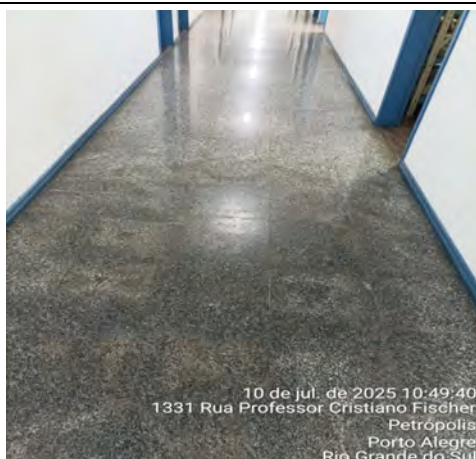
Imagem 143 – Piso de granito apresenta superfície desgastada, com perda de brilho e presença de manchas
