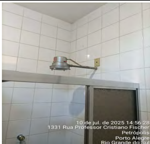
Imagem 187 – Chuveiro antigo, com funcionamento inadequado e estrutura metálica exposta, apresentando risco potencial de choque elétrico e comprometendo a segurança dos usuários
