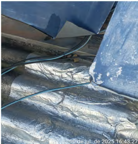
Imagem 31 – Fiação exposta na cobertura
