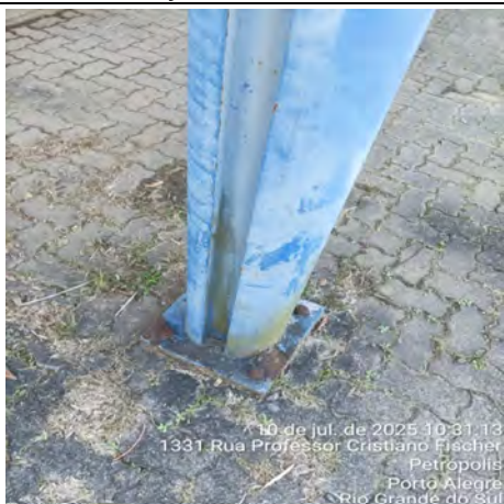
Imagem 23 – Sapatas dos pilares metálicos da cobertura estacionamento com pintura queimada e envelhecida e ferrugem
