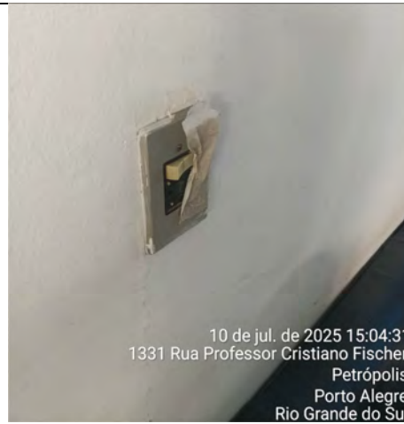
Imagem 46 – Tomadas quebrada e fora do padrão e norma NBR 14136
