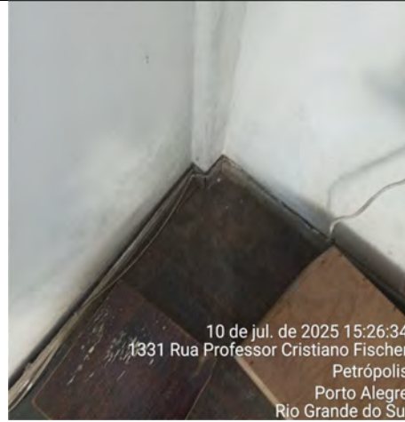
Imagem 36 – Fiação exposta passando pelo rodapé de madeira
