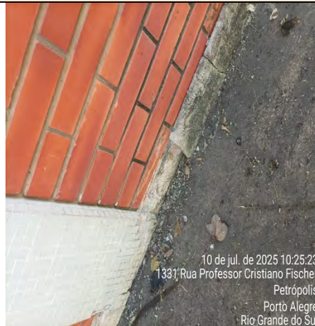
Imagem 212 – Ausência de rodapé de concreto
