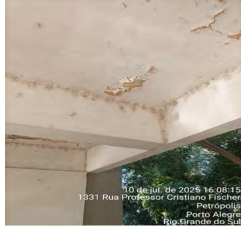
Imagem 240 – Pintura da laje do térreo da garagem com descascamentos, deslocamentos e manchas diversas
