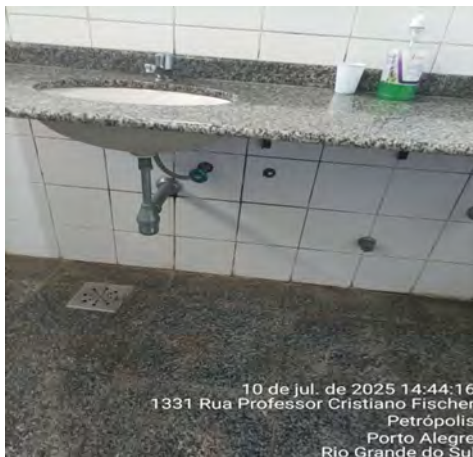
Imagem 183– Engastes flexíveis e sifões apresentam funcionalidade comprometida em algumas bancadas, com risco de vazamentos e prejuízo à estanqueidade do sistema hidrossanitário
