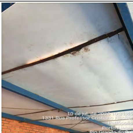
Imagem 21 – Cobertura em chapa metálica do estacionamento posterior com estrutura bastante fadigada e com patologias avançadas de ferrugem
