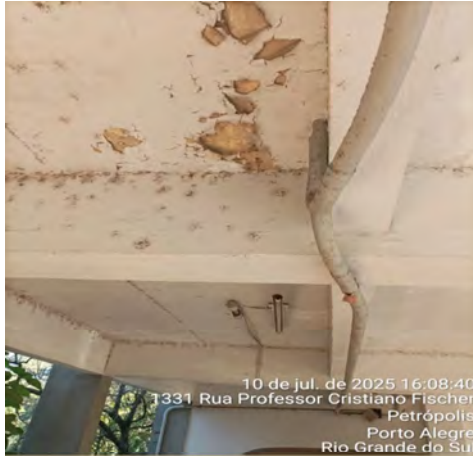
Imagem 239 – Pintura da laje do térreo da garagem com descascamentos, deslocamentos e manchas diversas
