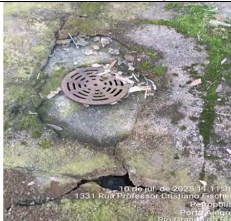
Imagem 164 – Piso da área de ventilação do auditório danificado e trincado, requerendo substituição total e reforma do sistema de captação de águas pluviais
