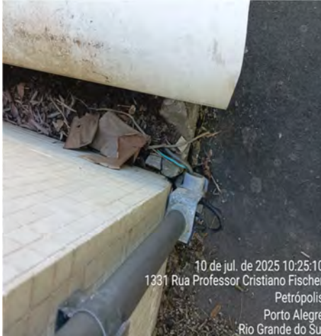
Imagem 85 – Fiações expostas na parte externa da edificação
