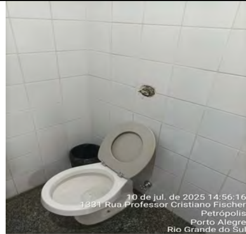
Imagem 186 – Válvula de descarga com ausência do acabamento de acionamento e presença de vazamento, além da tampa do vaso improvisada
