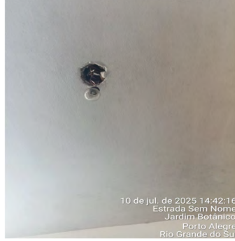
Imagem 50– Fiação expostas e lâmpada queimada
