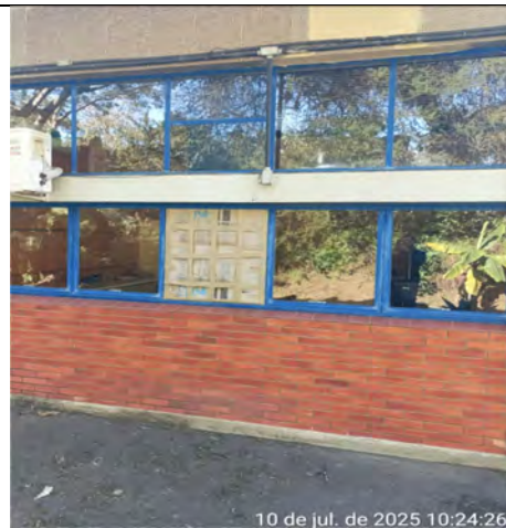
Imagem 108 – Esquadrias com pintura desgastadas e com vidro quebrado
