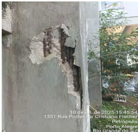
Imagem 245 – Pilar com Deslocamento da Capa de Concreto e Sinais de Impacto Mecânico, existência de oxidação na armadura
