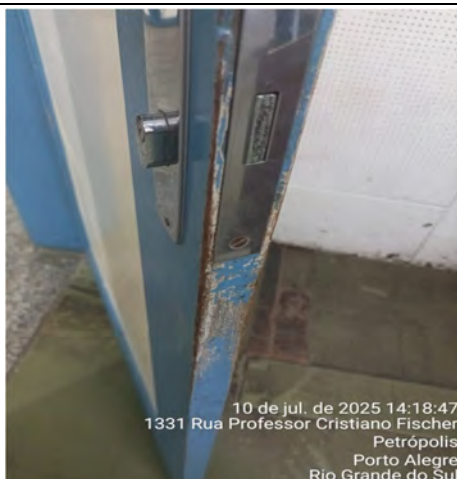
Imagem 95 – Portas com sinais de desgaste pelo tempo de uso e fechaduras danificadas
