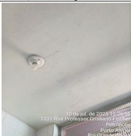
Imagem 117– Teto com presença de fissuras
