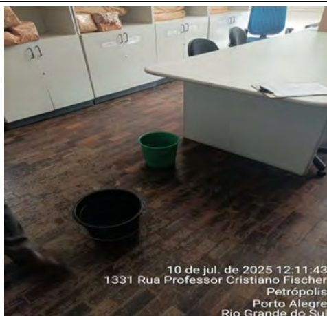
Imagem 155 – O piso de taco em madeira apresenta desgaste generalizado, com peças soltas em áreas pontuais e superfície do revestimento desbotada
