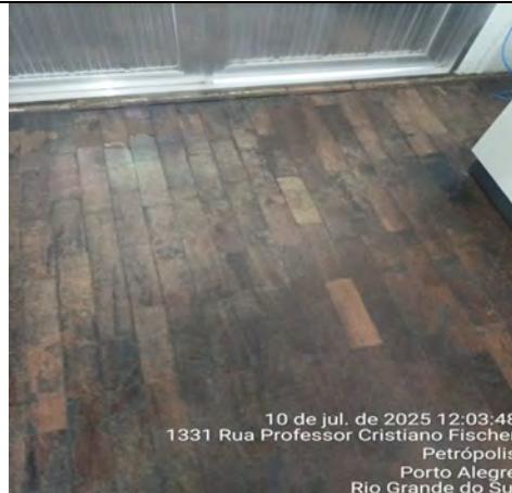
Imagem 150 – O piso de taco em madeira apresenta desgaste generalizado, com peças soltas em áreas pontuais e superfície do revestimento desbotada
