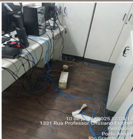
Imagem 73 – Cabos de rede e elétricos soltos sob o piso
