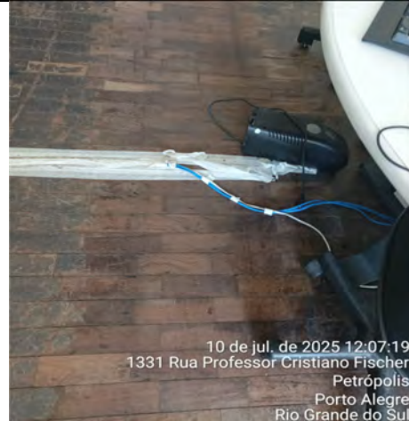
Imagem 70– Cabos de rede e elétrica passando sob o piso
