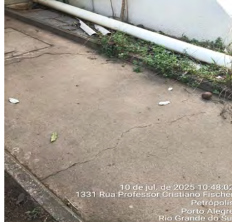
Imagem 170 – Calçadas externa da fachada posterior apresentando trincas localizadas em áreas pontuais
