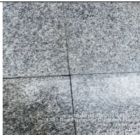
Imagem 142 – Diversas áreas do piso apresentam rejuntamento desgastado ou ausente, comprometendo a estanqueidade, facilitando a infiltração de sujeira e umidade
