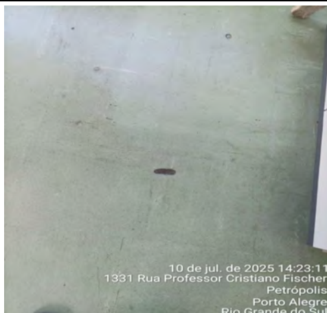
Imagem 161 – Salas com piso em paviflex antigo, danificado e com peças faltantes, demandando substituição do revestimento
