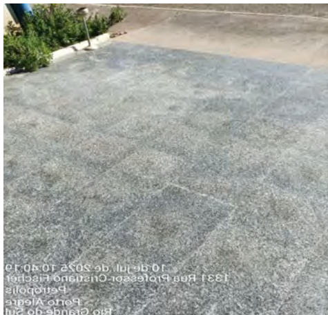
Imagem 139 – Piso de granito apresenta superfície desgastada, com perda de brilho e presença de manchas
