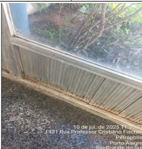
Imagem 101 – Esquadrias de alumínio com presença de lodo e ausência de vedação adequada
