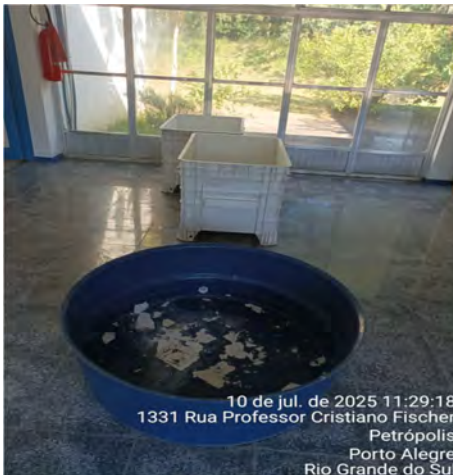
10 de jul. de 2025 11:29:18 1331 Rua Professor Cristiano Fischer Petrópolis Porto Alegre Rio Grande do Sul Imagem 129 – Deslocamento da massa e dos elementos do revestimento e da pintura do teto, provocado por infiltrações recorrentes
