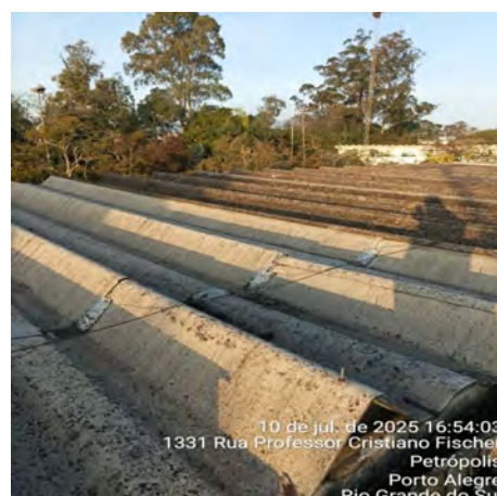
Imagem 6 - Telha Kalhetão quebradas e emendadas com manta
