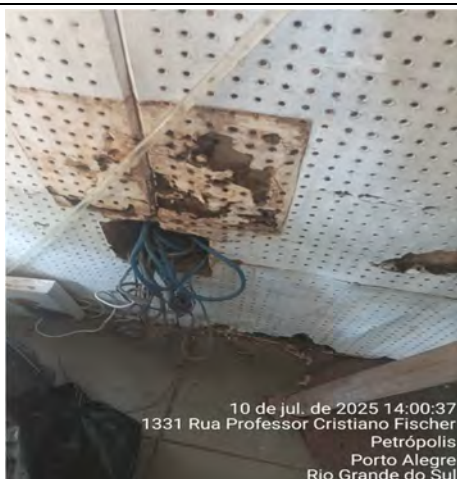
Imagem 63– Cabos de rede e elétrica passando nas mesmas caixas de passagem
