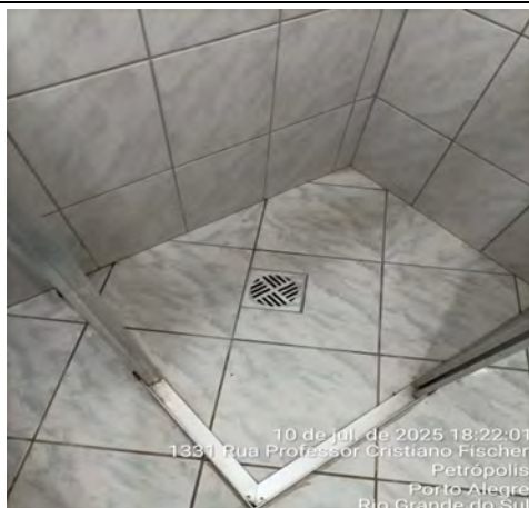
Imagem 171 – Revestimentos cerâmicos apresentando desagregação parcial do rejuntamento, demandando manutenção corretiva para restauração da estanqueidade
