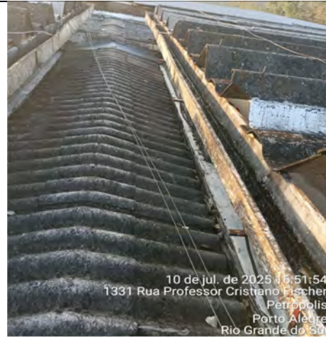
Imagem 28 – Fiação exposta na cobertura
