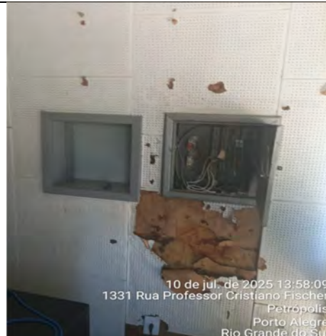
Imagem 138 – Placas de revestimento acústico coladas no teto, previstas para remoção devido ao desgaste e à quebra em diversos pontos, comprometendo sua funcionalidade e estética
