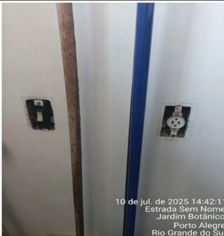
Imagem 51– Tomadas danificadas e fora do padrão e norma NBR 14136
