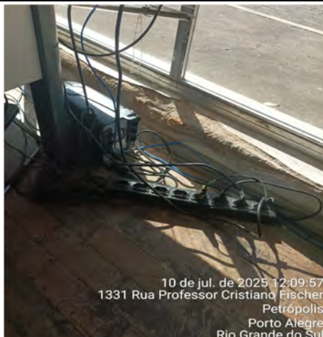
Imagem 69– Utilização de extensões podendo ter sobrecarga elétrica
