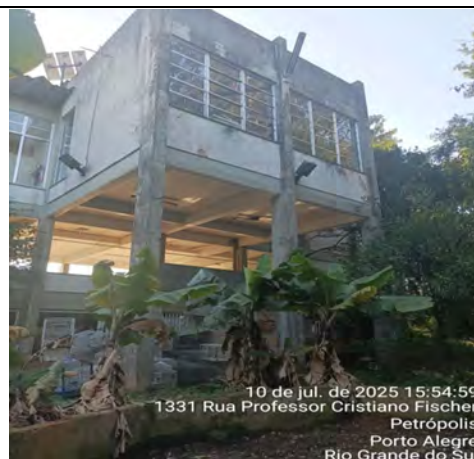
Imagem 250 – Paredes e elementos estruturais da fachada com pintura em péssimo estado de conservação
