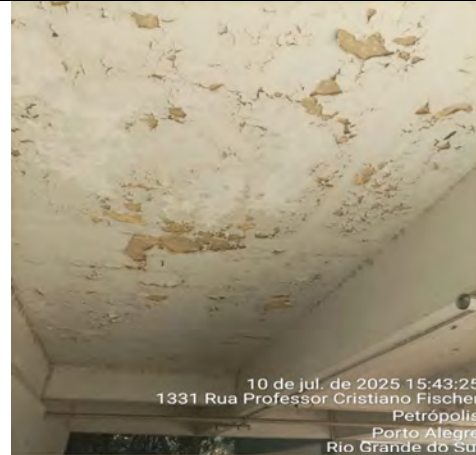
Imagem 242 – Pintura da laje do térreo da garagem com descascamentos, deslocamentos e manchas diversas
