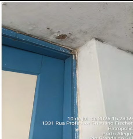
Imagem 119– Pintura do teto apresenta estufamento, com presença de umidade
