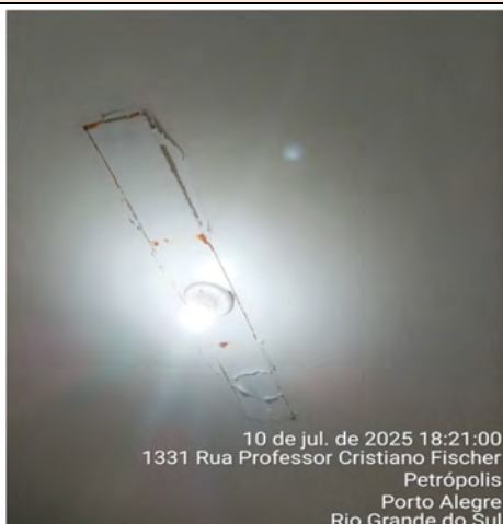
Imagem 115– Pintura do teto apresenta descascamento, indicando desgaste do revestimento
