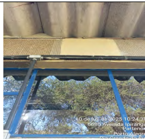
Imagem 214 – Áreas pontuais com ausência do revestimento (pastilhas)
