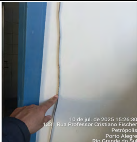
Imagem 37 – Fiação exposta passando pelo alisar da porta
