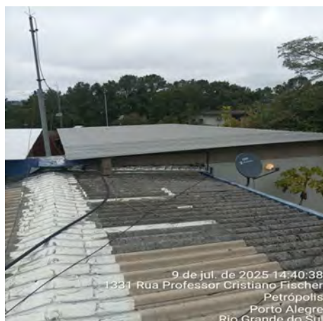
Imagem 15 – Cumeeiras e telhas quebradas emendadas com manta
