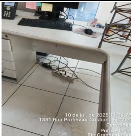
Imagem 79– Utilização de extensões podendo ter sobrecarga elétrica e solta sob o piso
