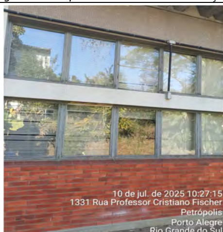
Imagem 107 – Esquadrias com pintura desgastadas e presença de oxidação
