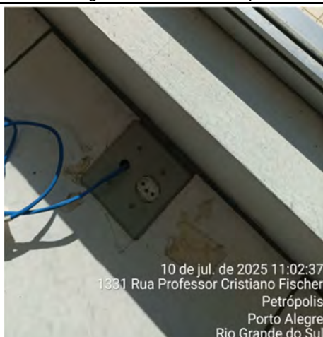
Imagem 81– Tomadas embutidas no piso sem vedação e fora do padrão e norma NBR 14136
