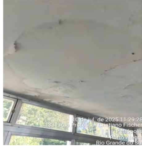
10 de jul. de 2025 11:29:28 1331 Rua Professor Cristiano Fischer Petrópolis Porto Alegre Rio Grande do Sul Imagem 130 – Pintura do teto apresenta descascamento, indicando desgaste do revestimento
