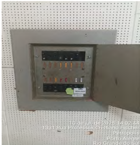
Imagem 61– Quadro metálico antigo, com componentes em desacordo com as normas técnicas vigentes.
