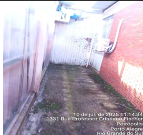
Imagem 226 – Manchas em diversas áreas do revestimento, decorrentes da ação das intempéries, acúmulo de sujeira, presença de fungos e desgaste natural da superfície
