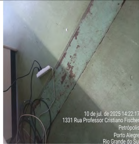
Imagem 58– Tampas metálicas das calhas de piso apresentam pontos de oxidação (ferrugem).
