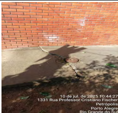
Imagem 217 – Manchas na Superfície do Revestimento – Indícios de Infiltração
