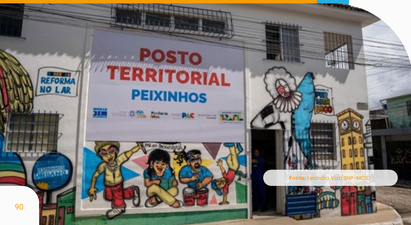
Figura 27: Posto territorial na Comunidade de Peixinhos em Olinda/PE, instalado em antigo prédio escolar, com espaço de atendimento e minimuseu no térreo e salas para reuniões e atividades comunitárias no pavimento superior
