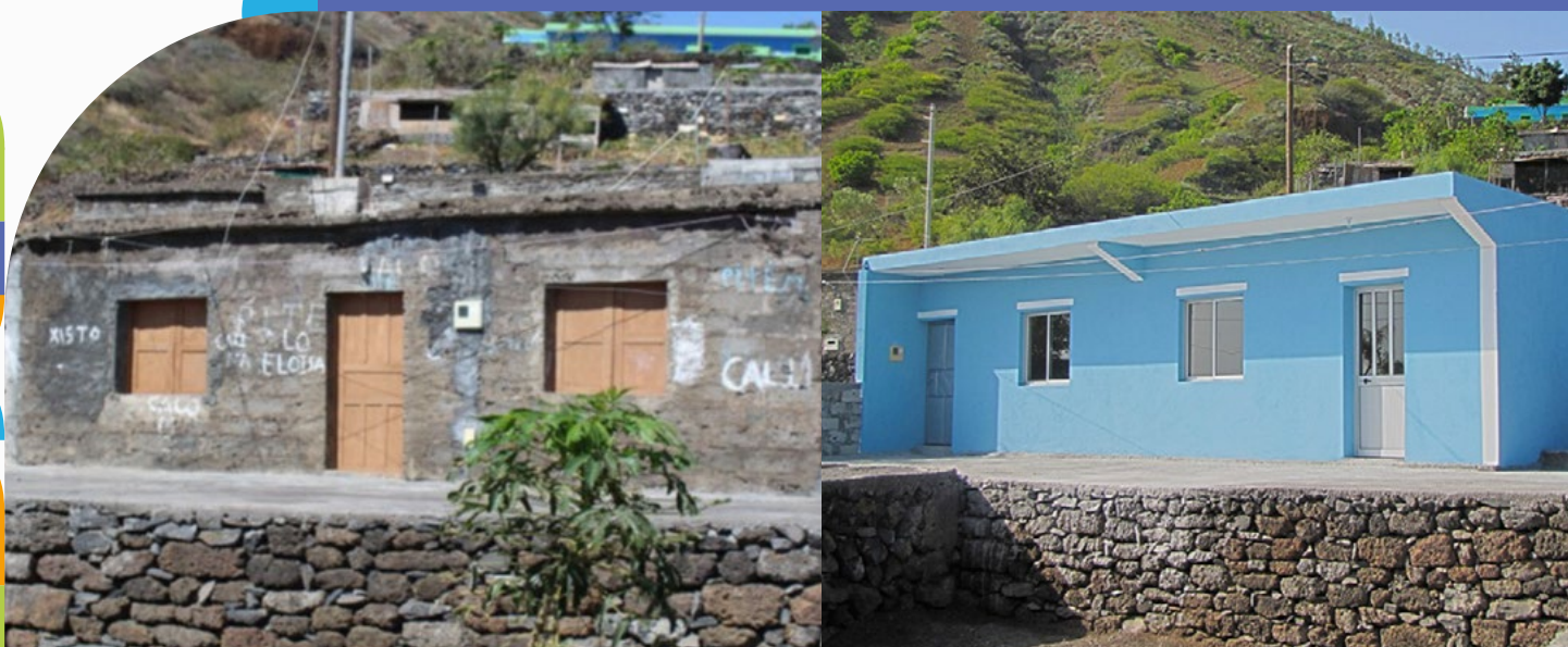
Figura 17: Antes e depois de habitação reabilitada como parte do PRRA
