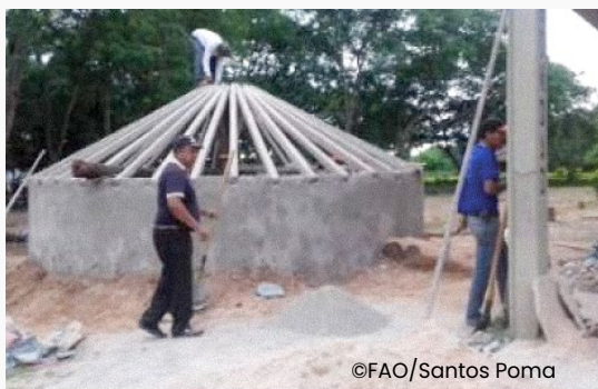
Imagen 10. Techado de la cisterna en Charagua
