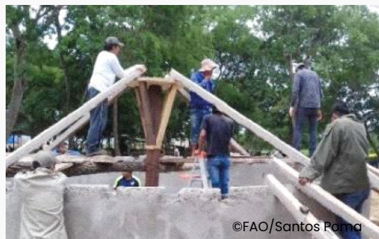
Imagen 10. Techado de la cisterna en Charagua
