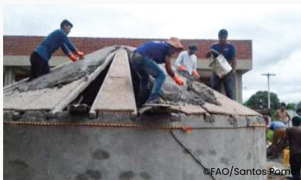
Imagen 10. Techado de la cisterna en Charagua
