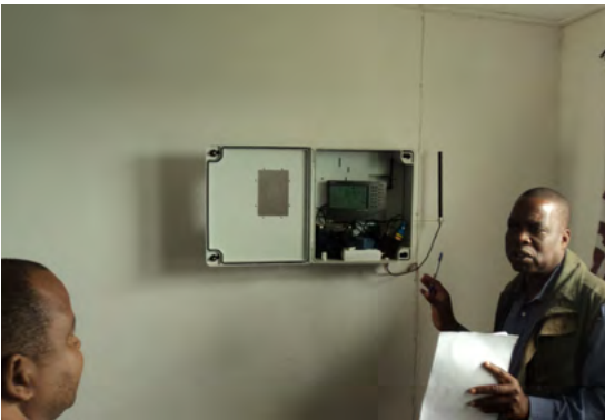
Instalación de equipos Fuente: Banco de Fotos GIZ MZ
